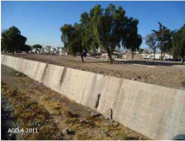
Figura 352: Margen derecha del Zanjón Frías, despejado de las villas que la ocupaban
