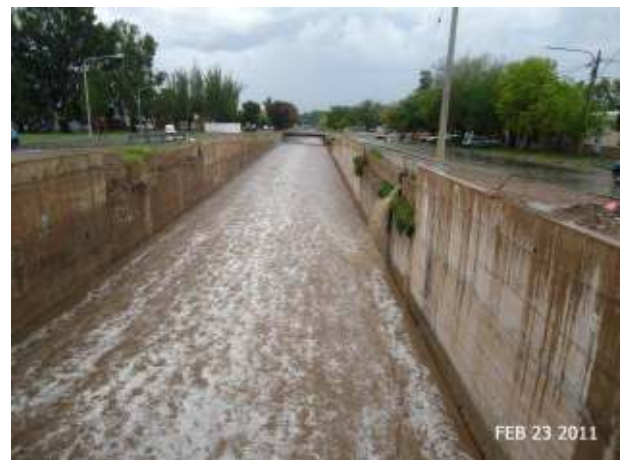
Figura 217: Descarga al Zanjón Maure durante una crecida aluvional, la que encontró a la compuerta baja, a pesar de la tormenta y las previsiones del radar meteorológico.
