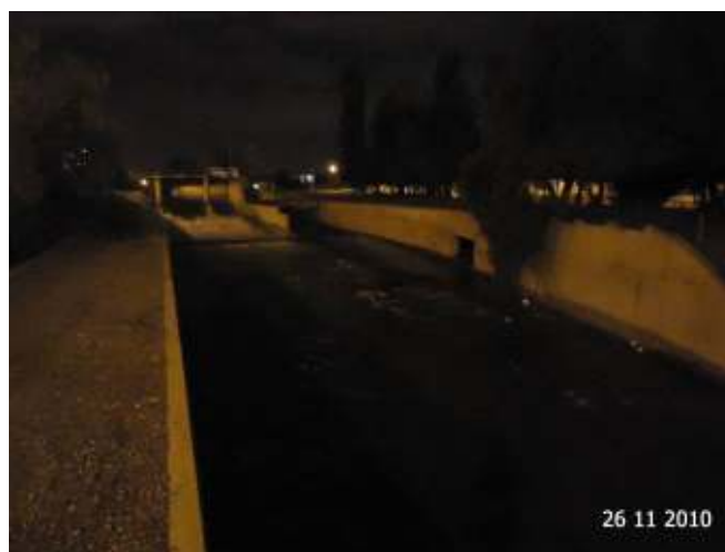
Figura 128: Crecida pluvioaluvional nocturna en la desembocadura del Zanjón Maure. Las compuertas de ataje del Dique Tajamar se encuentran bajas, hecho que siempre debe evitarse de manera preventiva.
