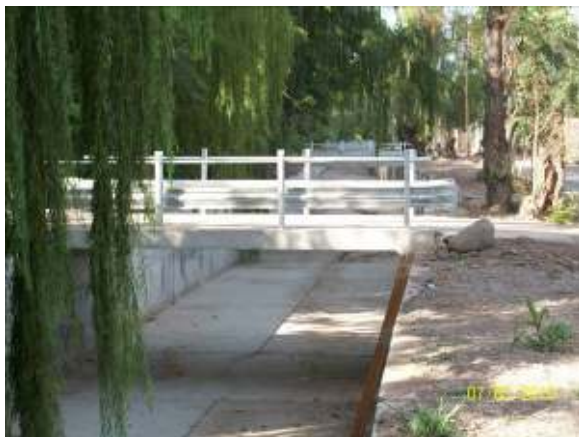
Figura 175: Puente sobre el revestimiento que reemplazó a un badén de acceso, en contraposición evidente con las figuras anteriores.
