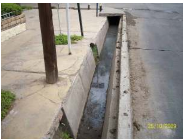
Figura 367: Moreras implantadas muy lejos del cauce de la acequia, con una ventana para que la humedad esté más accesible para el sistema radicular. Puede observarse que en la próxima existe un punto bajo sin desagüe, donde se acumulan los sedimentos y RSU.
