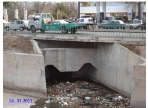
Figura 393: Desembocadura en el Zanjón Frías del Colector paralelo a calle Segura en Godoy Cruz, en la zona de vías.
