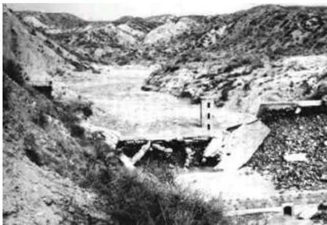
Figura 46: Fotografía general hacia aguas arriba de las ruinas del Dique Frías
