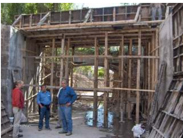
Figura 192: Etapa de obra del puente canal de la Hijuela Chacras de Coria. Al fondo la vieja estructura, se mantuvo en servicio hasta último momento.
