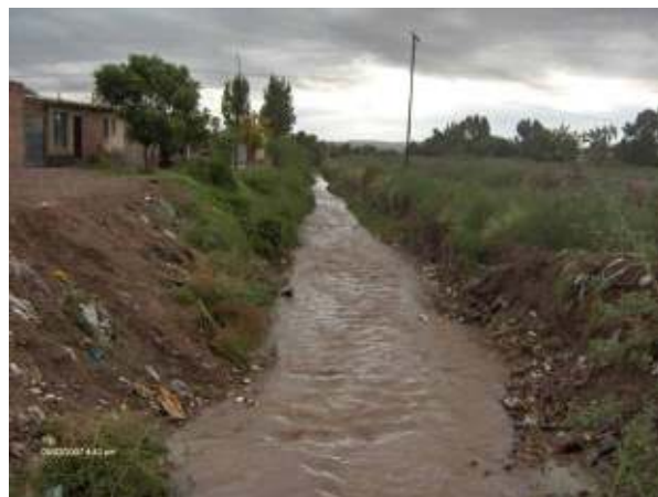
Figura 360: Sección aguas abajo de calle Río Diamante, donde la pendiente del cauce es mayor. Vista hacia aguas abajo, luego de la tormenta del 09 de febrero de 2007.
