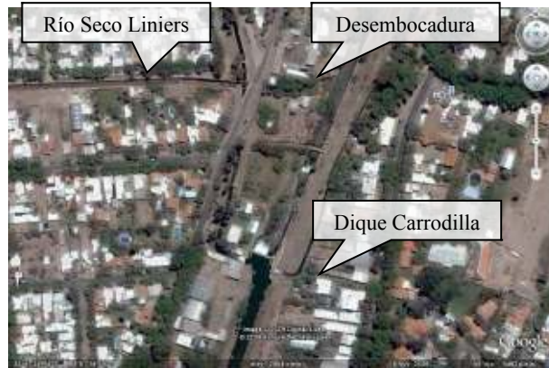
Figura 140: Desembocadura del Río Seco Liniers aguas abajo del Dique Carrodilla. La obra de aquietamiento y disipación de energía se encuentra angulada con el Canal Cacique Guaymallén.
