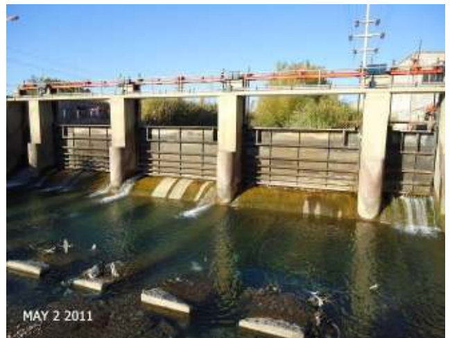
Figura 137: Vista aguas abajo del Dique Carrodilla
