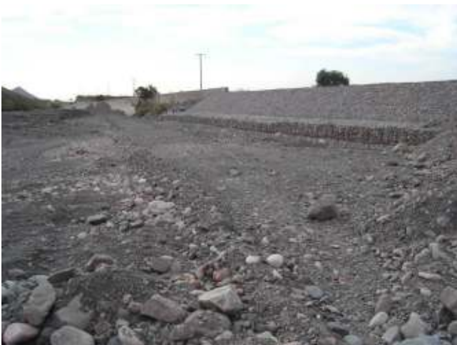
Figura 82: Refuerzo del terraplén con colchonetas, geotextil y hormigón de revestimiento antivandálico.
