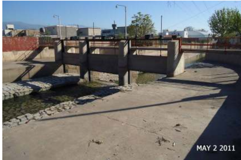
Figura 142: Dique Pilar, origen de la derivación bajo la reja debajo del aliviadero de margen derecha, del Canal Alejandro Mathus Hoyos.
