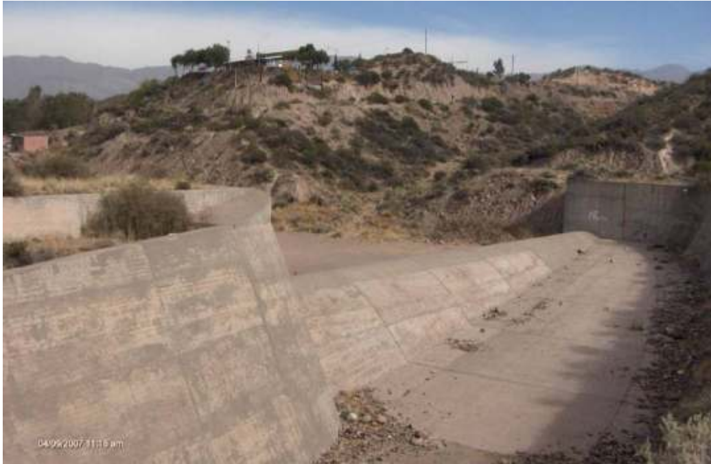
Figura 52: Vertedero lateral de margen izquierda.
