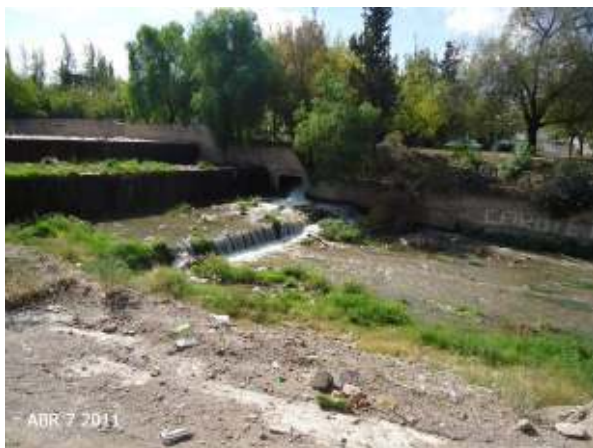
Figura 235: Descarga del Sifón de Cruce del Canal Jarillal
