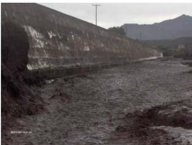
Figura 76: Erosión del pie del azud San Isidro durante la cola de la crecida del 28 de enero de 2007
