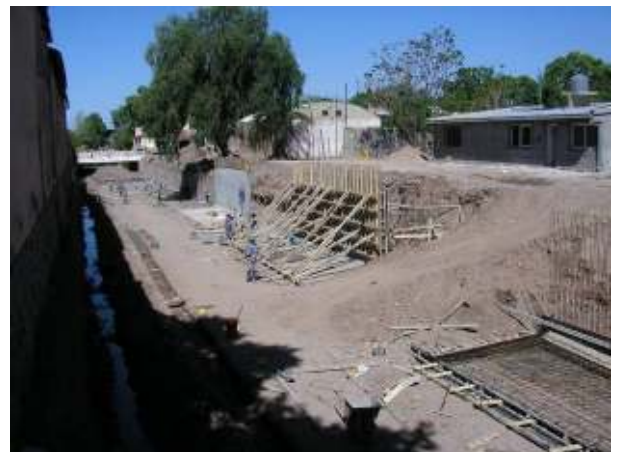
Figura 231: Revestimiento de la margen derecha del cauce, aguas abajo de la calle Belgrano. Etapa III del Revestimiento
