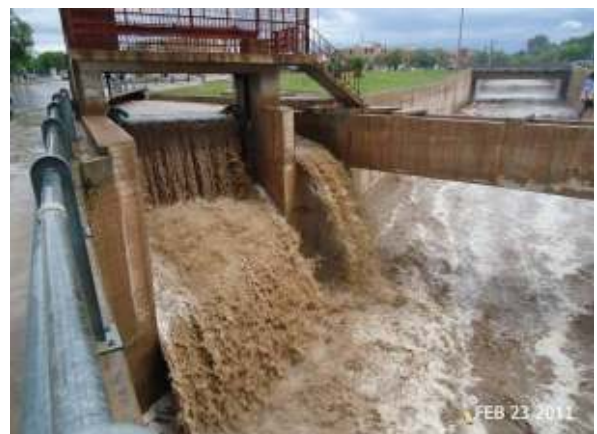
Figura 307: Vista del descargador al Zanjón Maure durante una crecida aluvional. Puede observarse el funcionamiento de la compuerta como vertedero
