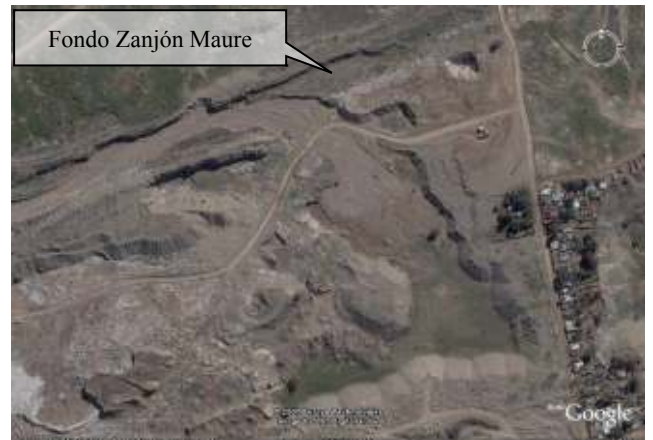
Figura 206: Detalle de la ripiera que avanzó sobre la margen derecha del Zanjón Maure provocando su derrumbe. Existe una diferencia de cota importante entre el fondo del cauce y los fosos de la ripiera fuera de uso.
