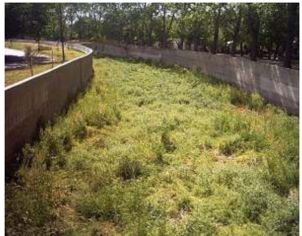
Figura 223: Tramo urbano antes de las limpiezas habituales que realiza la Dirección de Hidráulica con maquinaria propia.
