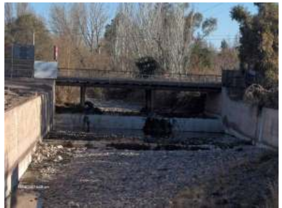
Figura 110: Puente Calle Baigorria. La edad del puente puede evaluarse por su tipología de pilas intermedias que ofrecen un obstáculo a las crecidas.
