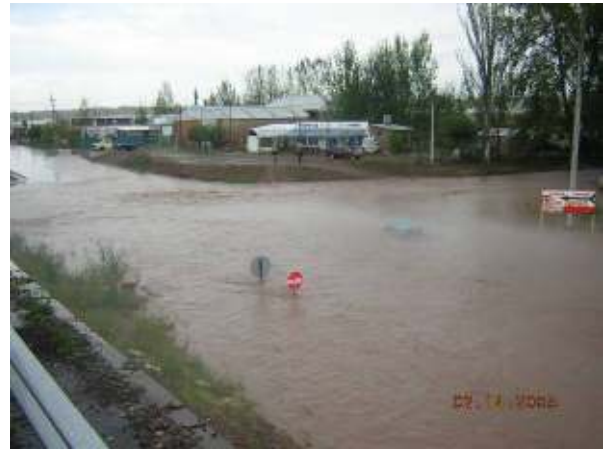
Figura 6: Crecida aluvional en la calle Olavarría, la cual cubre todo el cruce aguas arriba de la Ruta 7. La acumulación de agua cubre un R12. puede verse la magnitud por el agua en el cartel de pare.
