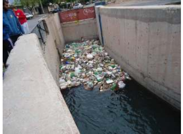
Figura 323: Sifón del Canal del Oeste en servicio. Los RSU son una constante en todos los sifones.
