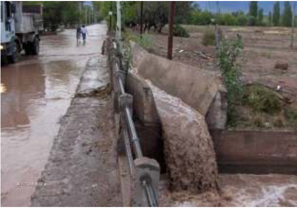
Figura 107: Desembocadura y aporte de caudales de la calle canal Pueyrredón en el Canal Caci que Guaymallén.
