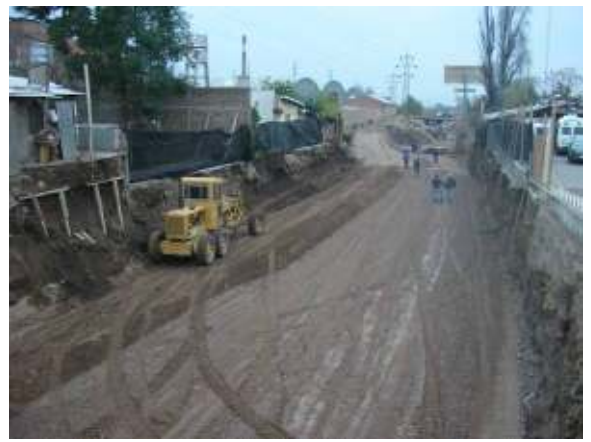
Figura 116: Etapas de obra, desde calle Rivadavia
