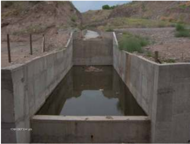
Figura 188: Desembocadura del Desagüe de excedentes pluviales que coincide con la traza del IV tramo del Corredor del Oeste, aguas abajo del cruce con ruta Panamericana
