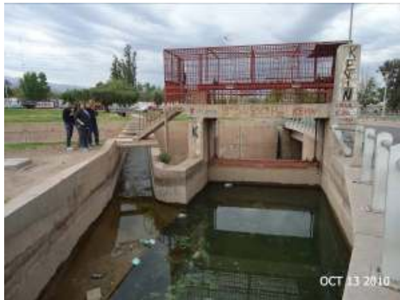
Figura 304: Vista desde aguas arriba del descargador y la canaleta del Canal Jarillal
