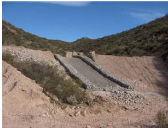
Figura 453: Hormigonado de la solera de la rápida del aliviadero
