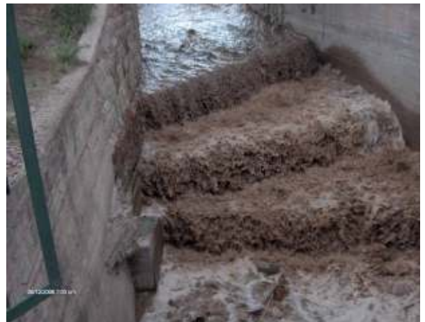
Figura 197: Salto triple aguas arriba del puente del ferrocarril.
