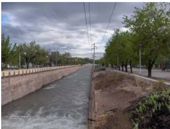
Figura 123: Tramo aguas debajo de calle Brasil
