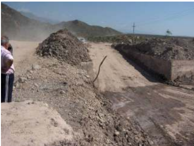
Figura 443: Etapa de desembanque del tramo correspondiente al badén de la Ruta Provincial N°13.
