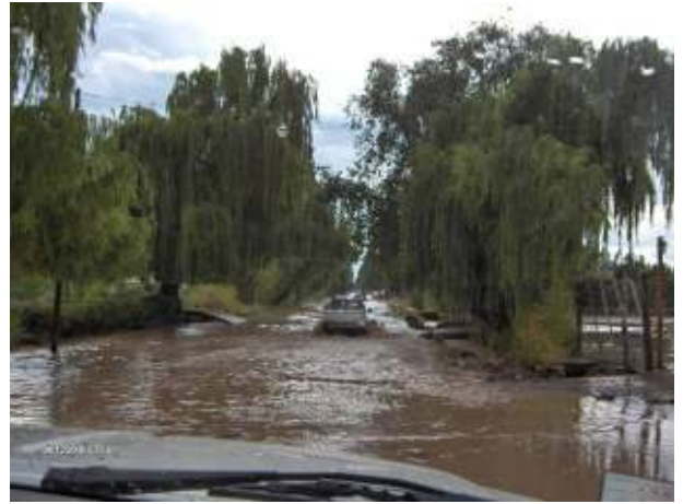
Figura 401: Calle Guardia Vieja, totalmente inundada por los desagües de riego de Vistalba y que aporta sus caudales a la calle Almirante G. Brown y al Desagüe de calle Longone.
