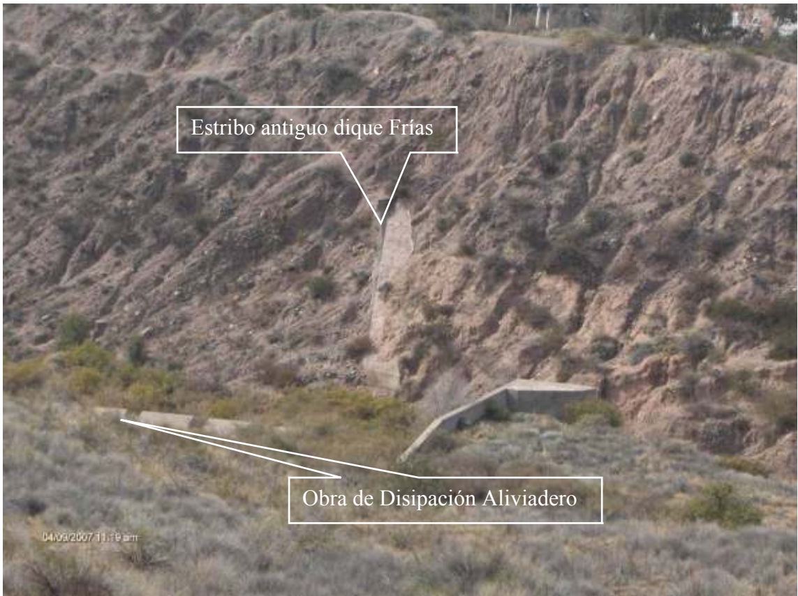
Figura 54: Obra de disipación de energía y salto de esquí. Restos del antiguo dique.
