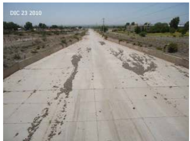
Figura 265. Canal Papagayos revestido en su tramo oeste – este. Obra de Transición.
