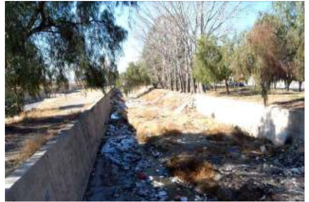
Figura 357: Vista urbana del colector escudo, con muros a ambos lados del cauce, a fin de proveer de la mayor seguridad al puente del área de influencia.
