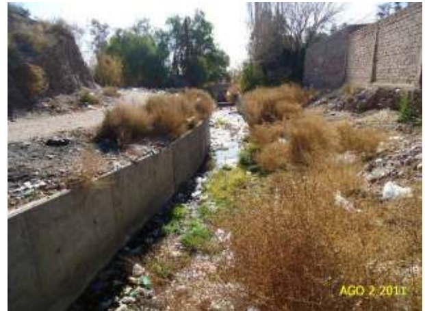
Figura 310: Vista hacia aguas abajo del cauce, donde el final de la foto corresponde al Canal Civit. Sobre la calle lateral, sobre margen izquierda, se realiza la labor de clasificación de los RSU.
