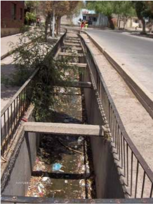
Figura 316: Vista de una de las ramas del Colector que va a cada costado de la calle.
