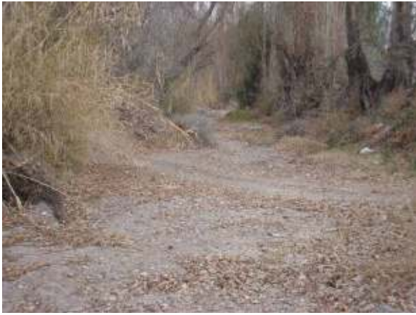
Figura 171: Vista de la sección del Río Seco Viamonte aguas arriba de calle Orsini. Puede observarse en primer plano uno de los cuatro badenes existentes.
