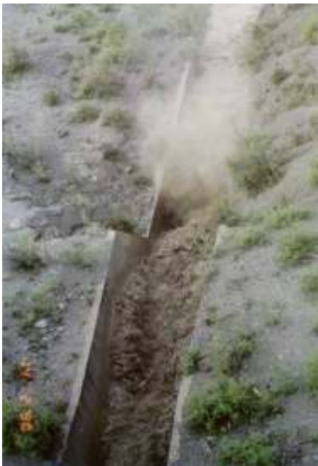
Figura 63: Fotografías del canal de evacuación de una de las torretas de la descarga de fondo, en funcionamiento y en reposo
