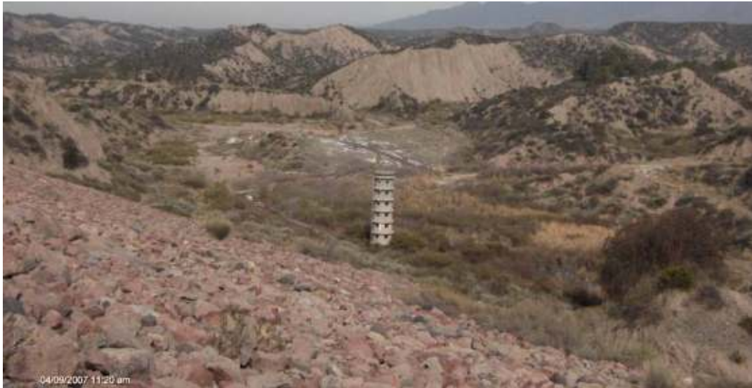
Figura 50: Fotografía del vaso de laminación y la torreta en el centro del tercio de margen izquierda
