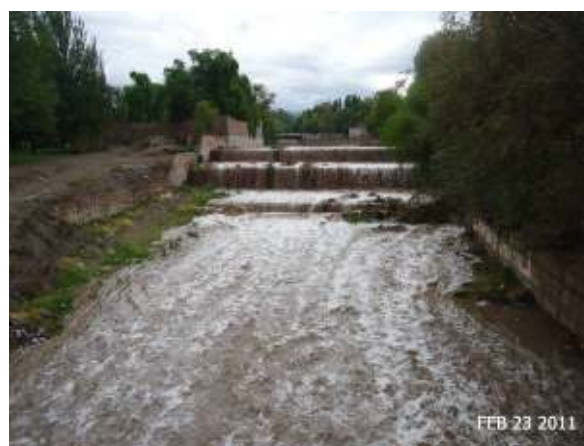
Figura 241: Vista del cauce del Zanjón Frías con el solo aporte del Canal Gorriti, aguas abajo del triple salto.
