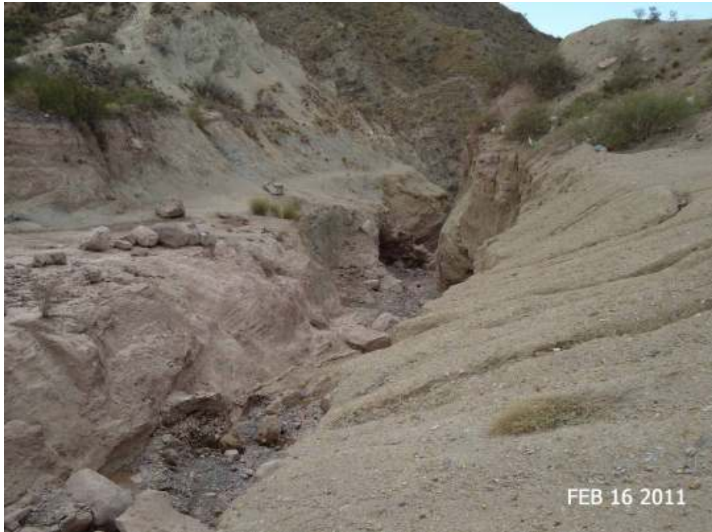
Figura 94: El cauce tiende a retomar los niveles originales.
