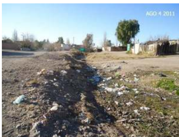
Figura 347: río seco emisario de la cuenca 305 visto hacia aguas abajo. A la izquierda se aprecia la calle Vistalba .
