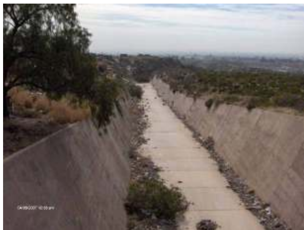
Figura 38: Canal de Evacuación del Aliviadero de Margen Derecha.
