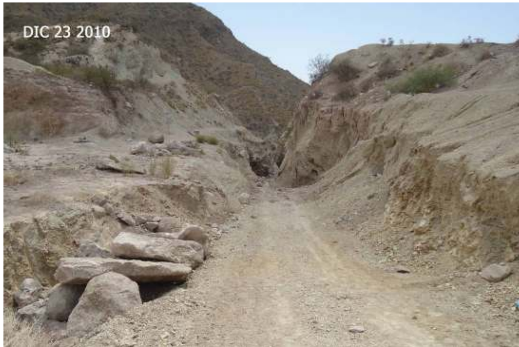
Figura 90: Rampa de acceso hacia el sector de la Garganta del Diablo. Vista hacia aguas abajo.
