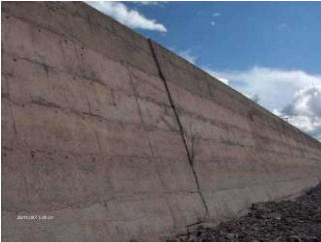
Figura 78: Movilización de uno de los paños del Azud San Isidro
