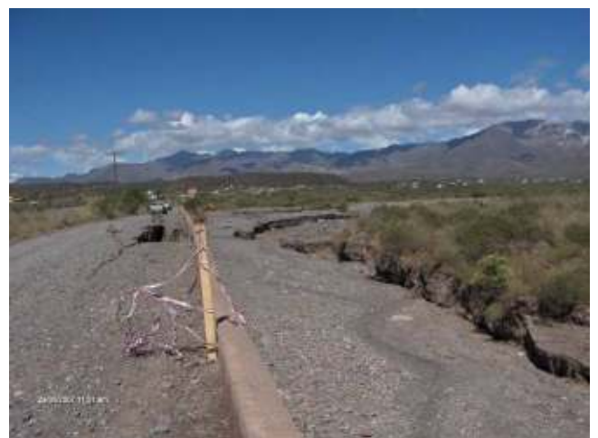
Figura 77: Estado final del Azud San Isidro luego de las tormentas del 24 al 28 de enero de 2007.
