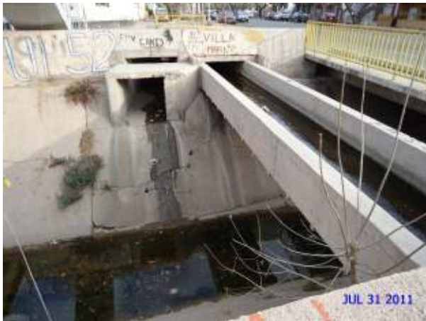
Figura 282: Sección trapezoidal con el puente canal correspondiente al Canal Tajamar, aguas abajo de Avenida San Martín.
