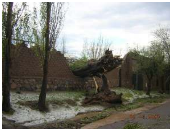
Figura 10: Efectos de la tormenta convectiva que se traducen en caída de un árbol destruyendo una pared, las hojas y ramas arrancadas de los árboles, granizo acumulado en el suelo y escorrentía superficial proveniente de la crecida aluvional
