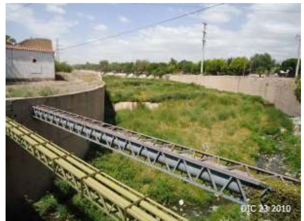
Figura 269: Embocadura del Zanjón de Los Ciruelos y finalización del Canal Papagayos con amplio desarrollo vegetativo
