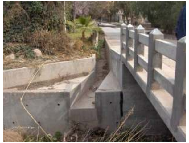
Figura 185: Detalle de las desembocaduras de los desagües pluvialuvionales de calle Malvinas sobre el cauce.
