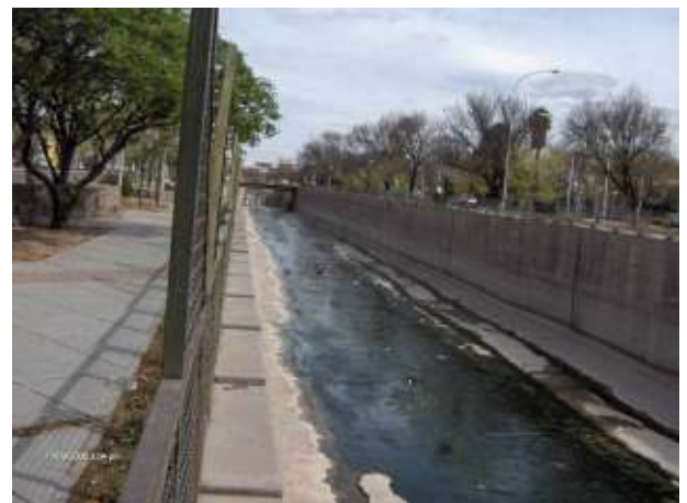
Figura 124: Tramo revestido en la Capital, limitando con Guaymallén, vista hacia aguas arriba
