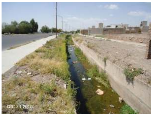
Figura 361: Tramo revestido aguas arriba de calle Diamante
