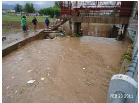
Figura 305: Vista desde aguas arriba del descargador y la canaleta del Canal Jarillal durante una crecida aluvional y la compuerta baja.
