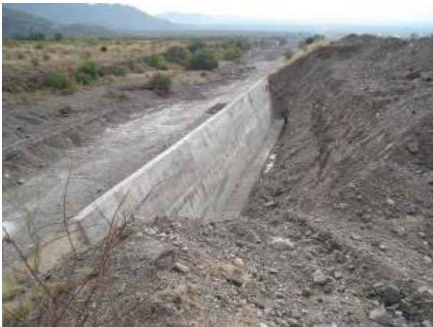
Figura 423: Tramo aguas arriba del triple salto, donde se restituyeron los muros dañados por los aluviones de enero de 2007.
