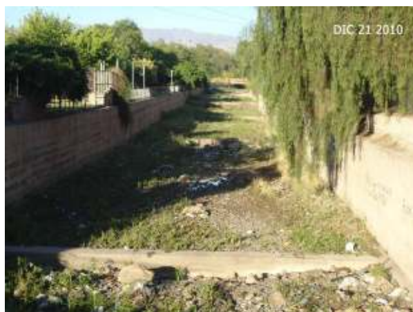
Figura 244: Tramo entre el corredor del Oeste y Calle Paso de Los Andes, donde el fondo sin revestir se encuentra estabilizado con dientes transversales para evitar el arrastre y erosión.
