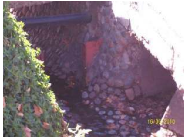
Figura 376: Detalle de una recata donde se colocan compuertas para orientar las dotaciones.
