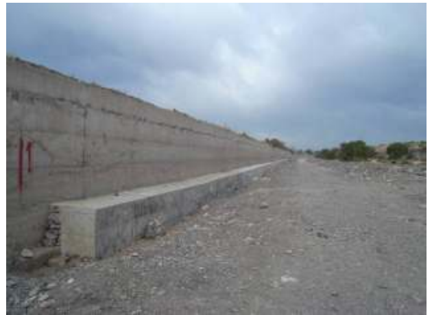
Figura 424: Tramo aguas arriba del triple salto, vista hacia aguas arriba. El pie del muro, de 3 metros de altura ha sido recalzado.
