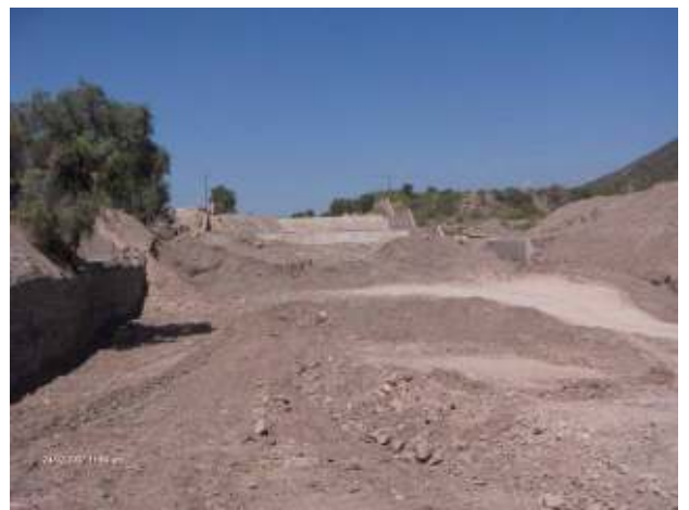
Figura 442: Vista completa del efecto de descalce y falla de los muros (al fondo)
