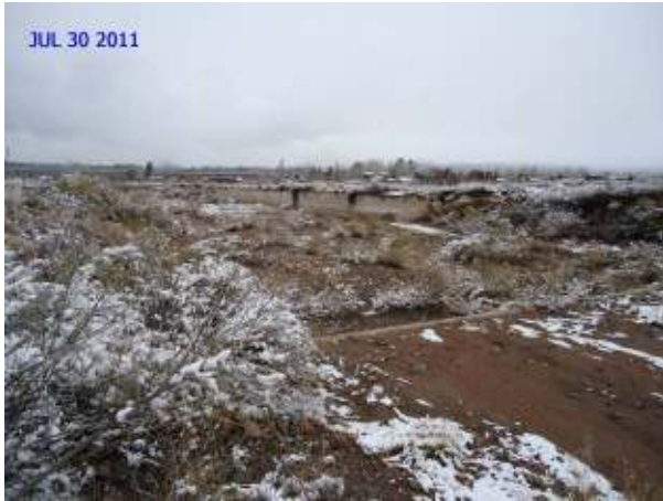
Figura 410: Vista del Colector Blanco Encalada hacia aguas abajo, desde el inicio del revestimiento
