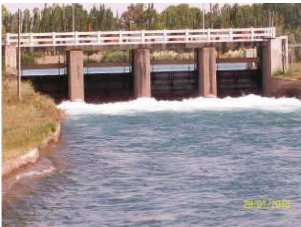
Figura 101: Edificio de compuertas del Canal Gran Matriz
