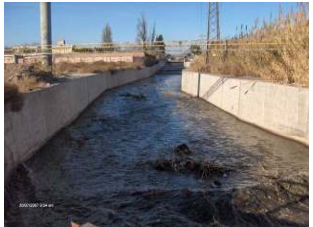
Figura 118: Cauce revestido del Canal Cacique Guaymallén luego de la obra del año 2005, durante el inicio del turno, luego de la corta anual del invierno de 2007. Pueden observarse la gran cantidad de basura que arrastra el frente de los caudales
