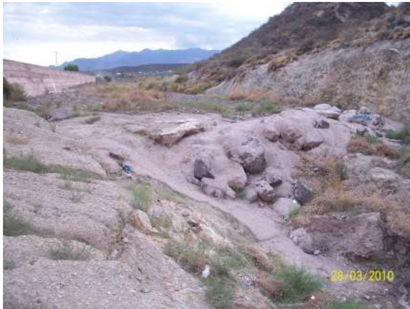
Figura 86: Imagen desde aguas abajo de la estabilización construida sobre la Garganta del Diablo
