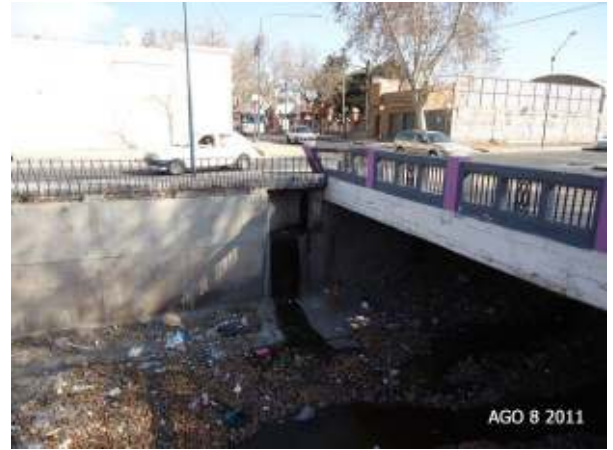
Figura 386: Desembocadura de uno de los colectores pluviales del sistema de la plaza de Godoy Cruz en calle Antonio Tomba.
