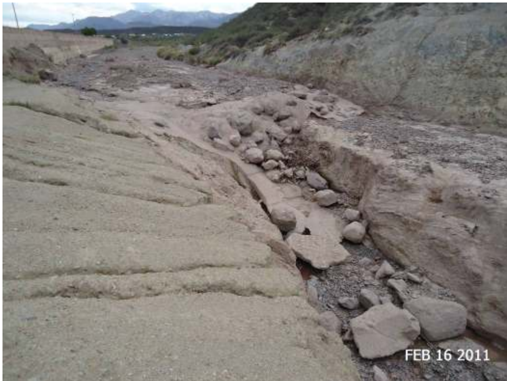
Figura 92: El camino de acceso a las excavaciones ha sido erosionado por las descargas aluvionales producidas durante la temporada estival de 2011.
