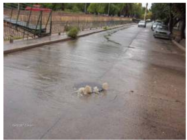
Figura 252: Calle lateral sur del Zanjón Frías. No solamente se saturan las redes de drenaje, sino también las cloacales, tal como se puede ver en el centro de la imagen, a través de la surgencia de la boca de registro. Si bien el agua que emerge es la proveniente de la lluvia, puede deducirse que la misma se encuentra contaminada con los efluentes cloacales que ha diluido el sistema. Esta es una contribución adicional a la contaminación de los cauces de las zonas distales de Lavalle, aguas abajo del compartó Jocolí.
