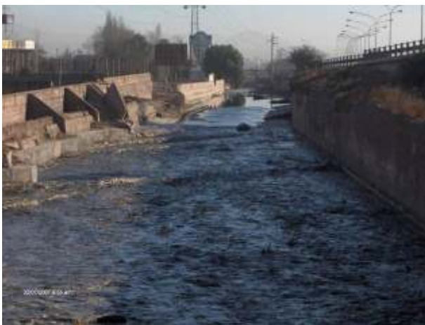
Figura 121: Liberación del Cauce aguas abajo del puente del ferrocarril luego de la corta anual de junio de 2007.
