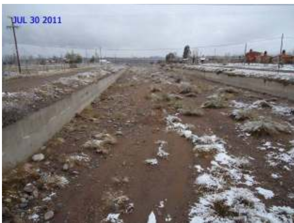
Figura 412: Vista hacia aguas abajo de las márgenes revestida, desde el Puente de la RP N°82
