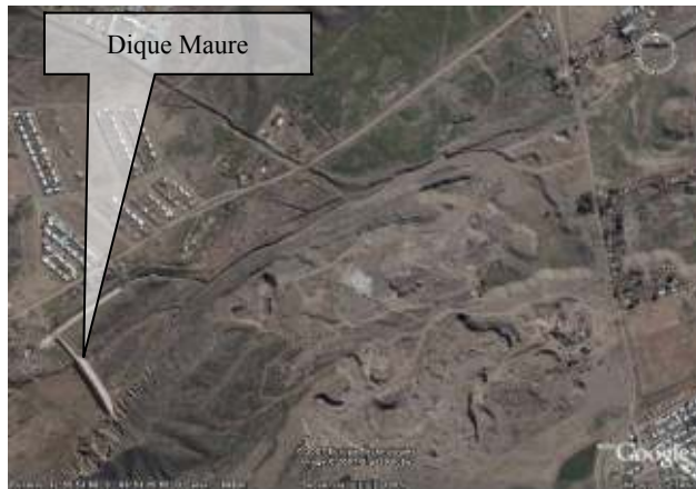
Figura 205: Imagen general del Dique Maure y las ripieras adyacentes aguas abajo del Zanjón Maure
