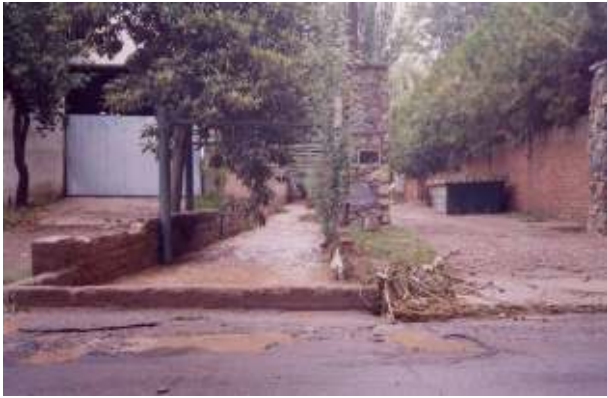
Figura 406: Desagüe entre calle Longone y Medrano, conduciendo las cola de los desagües de una crecida de verano
