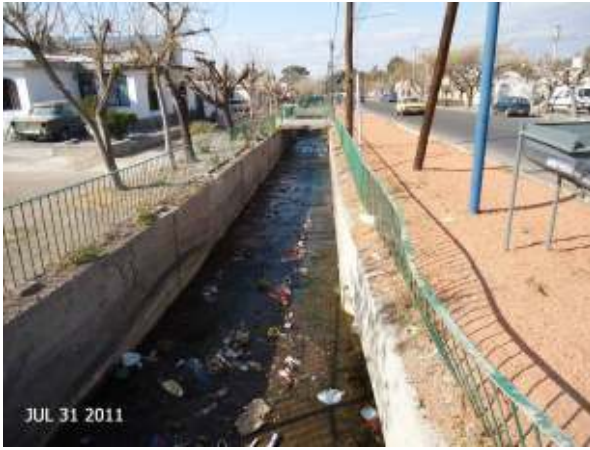
Figura 326: Colector Gorriti unificado por el costado norte de Calle Gorriti aguas abajo de calle Juncal
