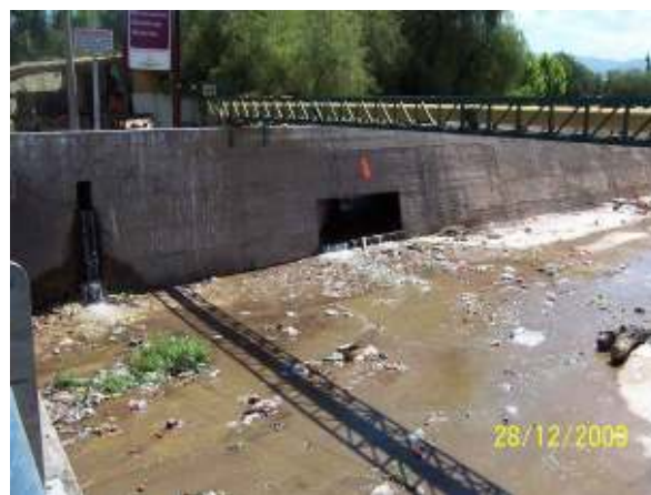
Figura 238: Detalle de la desembocadura, donde se aprecia los RSU que se aportan al cauce, puede apreciarse también el aporte de agua de riego del arbolado público.
