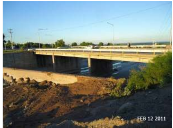
Figura 263. Obra de transición entre Río Seco y Canal Revestido.
