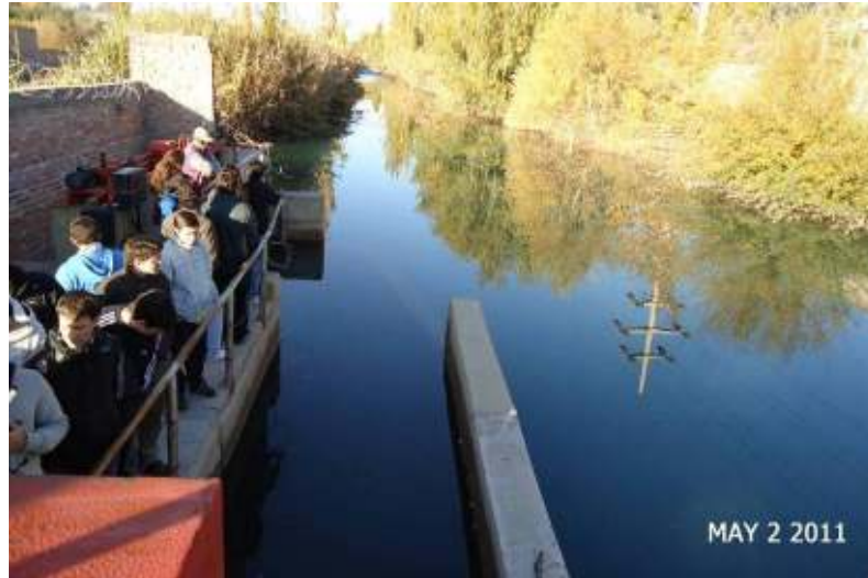
Figura 135: Sección del Canal Caci que Guaymallén aguas arriba del dique Carrodilla.
