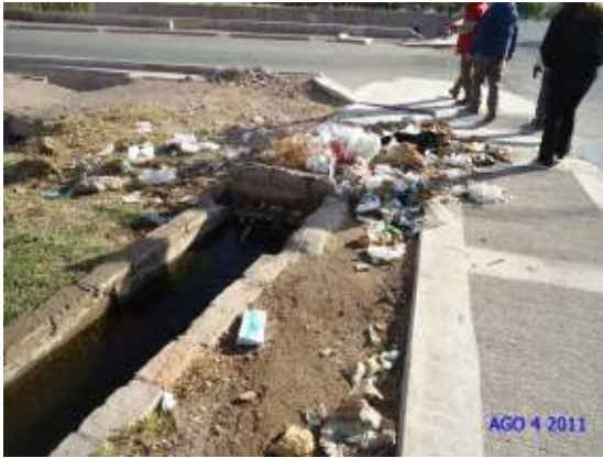
Figura 339: Debido a que la planta potabilizadora de Alto Godoy ha necesitado sucesivos refuerzos y el sifón del Canal Civit no alcanzaba para más de 1000 l/s debió reforzarse el caudal de la aducción mediante un cruce adicional al puente de calle San Vicente. Puede observarse los RSU que se acumulan diariamente y la Municipalidad debe retirarlos a fin de no aumentar la contaminación local y del agua conducida para su potabilización.
