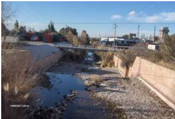
Figura 147: Batería de saltos y disipadores
