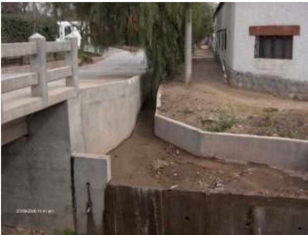
Figura 185: Detalle de las desembocaduras de los desagües pluvialuvionales de calle Malvinas sobre el cauce.
