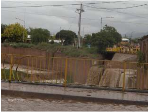
Figura 266: Desembocadura Colector Infanta, curva del colector Papagayos e inicio del Zanjón de Los Ciruelos, luego de la tormenta del 09 de febrero de 2007, vista desde el puente de Boulogne sur Mer
