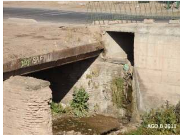
Figura 393: Desembocadura en el Zanjón Frías del Colector paralelo a calle Segura en Godoy Cruz, en la zona de vías.
