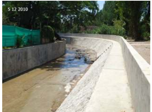
Figura 201: Curva terminada, transformando el río seco de la figura anterior en un canal revestido.
