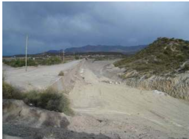
Figura 81: Cierre de la Garganta del Diablo para evitar la erosión del pie del azud
