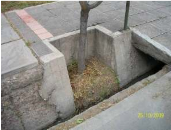
Figura 363: Árbol implantado de manera correcta, a nivel del fondo de la acequia con el fuste alejado del cauce
