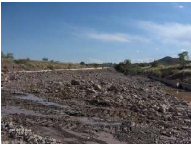
Figura 436: Vista del tramo aguas abajo del salto triple, mirando hacia aguas arriba. El embanque fue casi del 100%.
