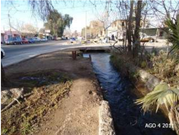
Figura 340: Canal Civit llegando al Zanjón Frías
