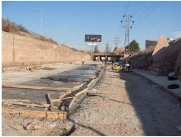
Figura 119: Trabajos de revestimiento aguas abajo del puente del ferrocarril durante el invierno de 2007, a continuación de la obra del revestimiento de Calle Rivadavia
