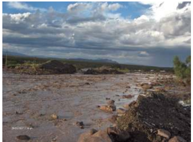
Figura 439: Descarga aluvional del día 28 de enero de 2007, vista desde lo que quedó del badén de la Ruta N°13 hacia aguas abajo. Puede verificarse que el trabajo realizado en dos días sobre la margen izquierda cumplió con el cometido de aliviar las descargas hacia el bajo de la Quebrada de Las Chilcas..
