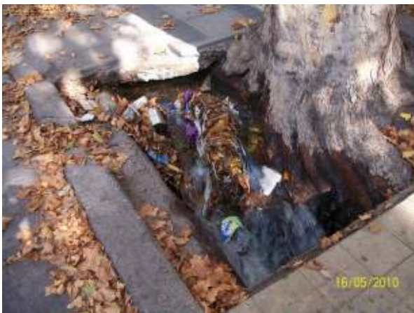
Figura 373: Detalle de la obstrucción que causa el fuste de un plátano entre dos puentes vehiculares, en combinación con los RSU y las hojas, luego de la ocurrencia un episodio de viento Zonda.
