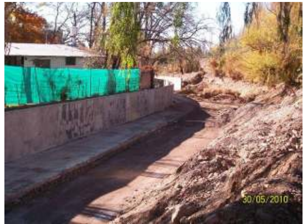
Figura 203: Trabajos de avance de obra del revestimiento del río seco en la curva, luego de la temporada estival
