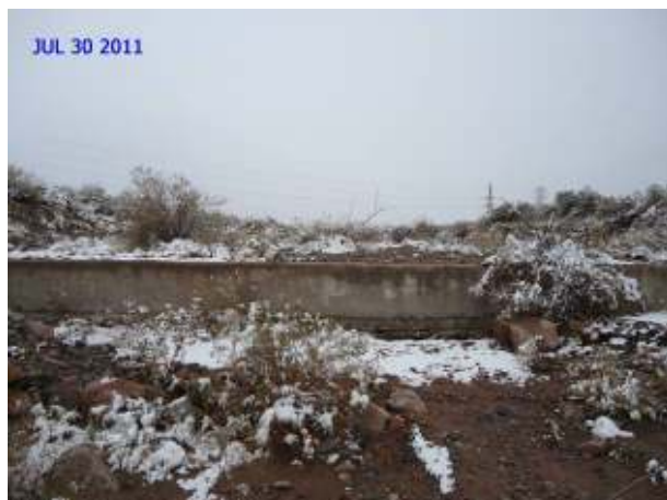
Figura 415: Vista del salto estabilizador inicial, donde comienzan los muros marginales.
