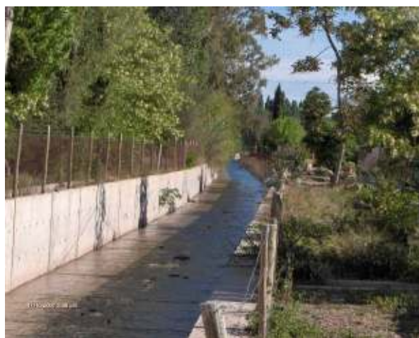
Figura 180: Sección del Río Seco Viamonte, con una descarga pluvial sobre la margen izquierda.
