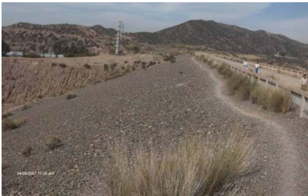
Figura 49: Fotografía del espaldón de aguas abajo
