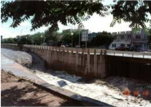
Figura 249: Desembocadura del Zanjón Frías en el Canal Cacique Guaymallén, durante la cola de crecida. Puede verse claramente que la corriente del tributario no tiene influencia sobre el escurrimiento aguas arriba del salto del cauce principal. 25
