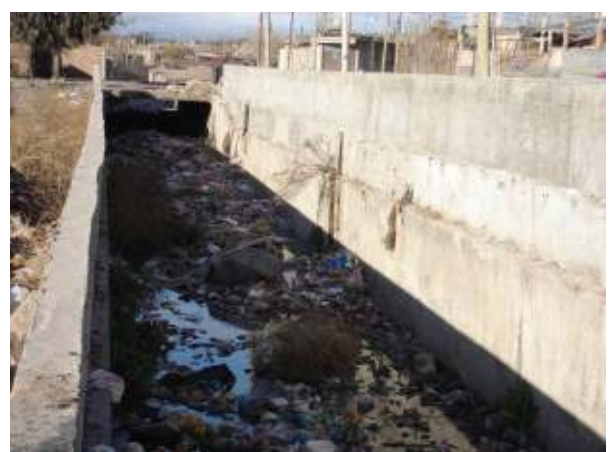
Figura 289: Vista de un tramo con los residuos y basura arrojados, además del material de aporte del torrente.
