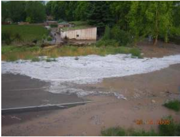
Figura 3: Acumulación de granizo aguas abajo de la Ruta 40, hacia el este. Puede apreciarse las hojas de los plátanos caídas sobre los techos.
