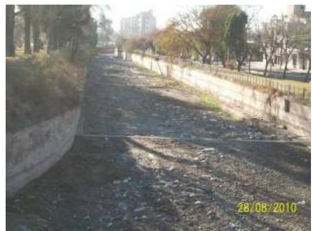
Figura 244: Tramo entre el corredor del Oeste y Calle Paso de Los Andes, donde el fondo sin revestir se encuentra estabilizado con dientes transversales para evitar el arrastre y erosión.
