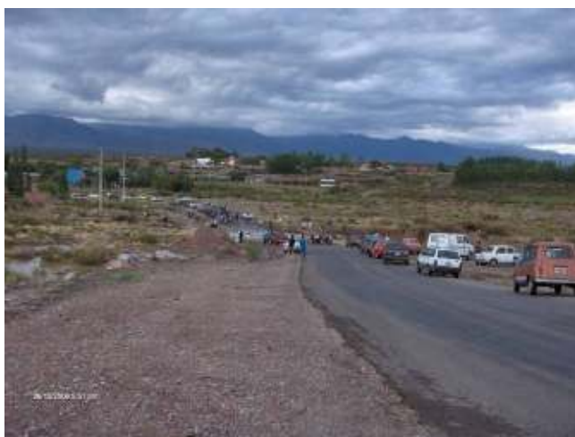
Figura 165: Torrente aguas arriba de la Ruta Panamericana. Corte de una vía de comunicación luego de una tormenta en el año 2007, en un sector urbanizado sin planificación ni autorización de las autoridades de aplicación a nivel hidráulico.
