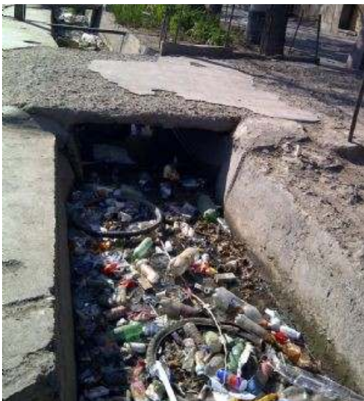
Figura 396: Estado del Canal Moyano paralelo a la Calle San Martín en Las Heras. (fotografía Diario Los Andes)
