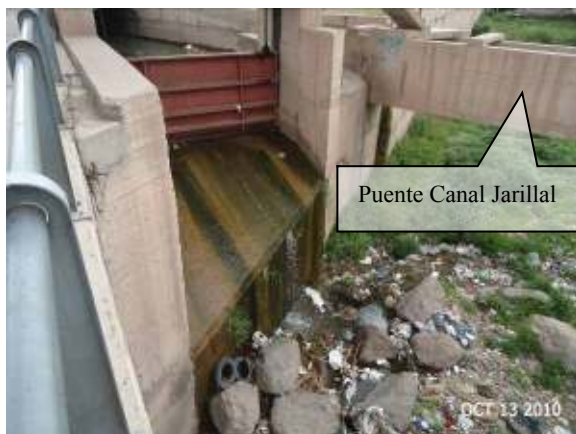
Figura 306: Vista del descargador al Zanjón Maure.
