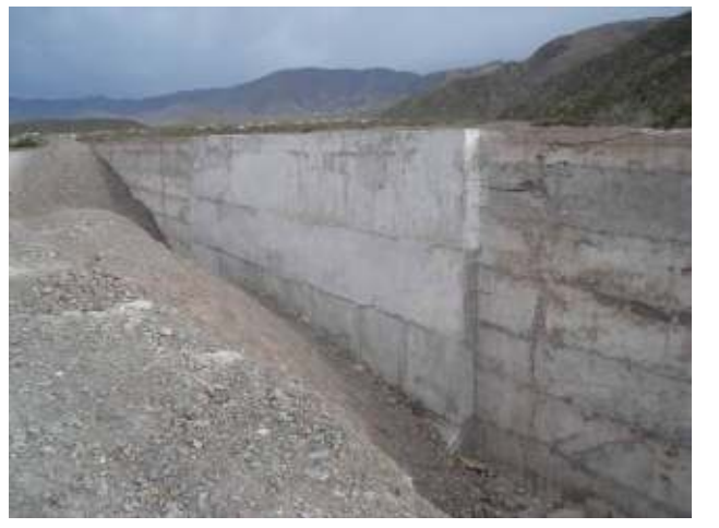
Figura 83: Refuerzo posterior de los muros movilizados del Azud San Isidro.
