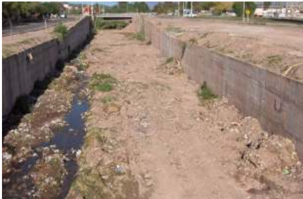
Figura 218: Tramo aguas abajo del Corredor del Oeste. Para la limpieza debían transportarse gran cantidad de material para poder solucionar la problemática del agua (margen derecha), erogada por los canales de Irrigación. Al fondo a la izquierda, puede verse la estructura de desagüe del Canal Jarillal.
