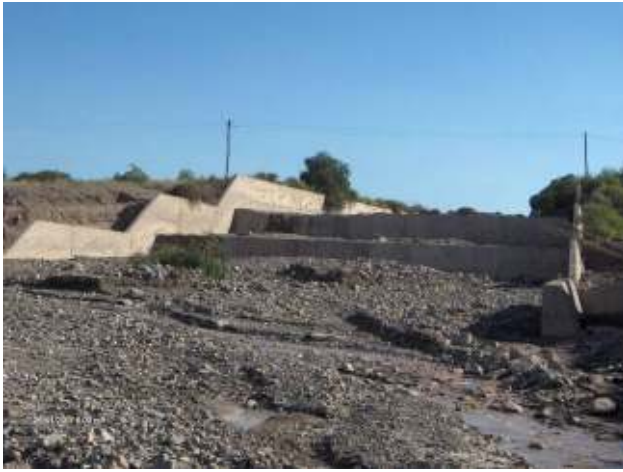
Figura 434: Vista del salto triple, cuyo embanque tapó por completo el tercer vano y su cuenco amortiguador.
