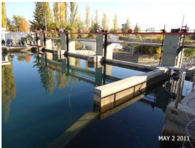
Figura 136: Vista aguas arriba del Dique Carrodilla
