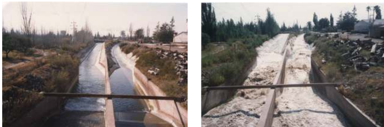
Figura 104: Nacimiento del Canal Cacique Guaymallén a la izquierda y del Canal San Martín a la derecha de cada una de las dos fotografías. En la imagen de la izquierda los canales se encuentran en época de corta, en cambio, a la derecha, ambos tienen dotaciones de riego durante un período rico del Río Mendoza ya que se los abastece de manera simultánea.
