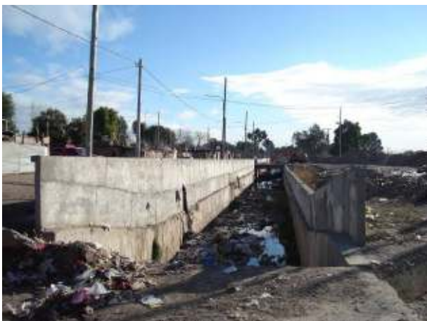
Figura 288: Sección Rectangular del Colector Los Cerrillos, visto desde uno de los numerosos puentes vehiculares existentes.
