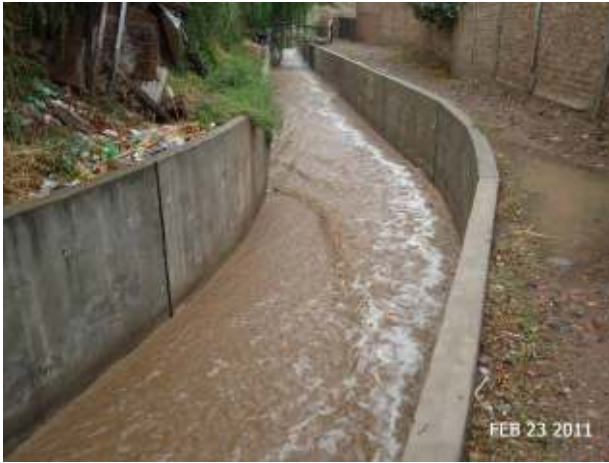
Figura 302: Vista de la sección revestida en Hormigón Armado.
