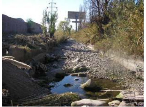
Figura 114: Vista aguas abajo del puente de Calle Rivadavia.
