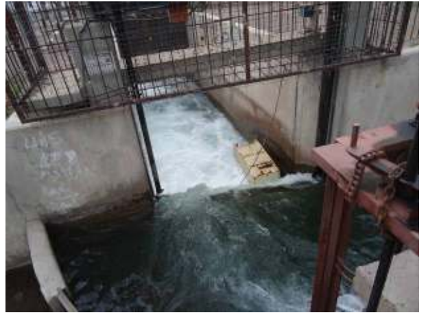
Figura 321: Derivación del Canal Jarillal hacia el Colector Gorriti
