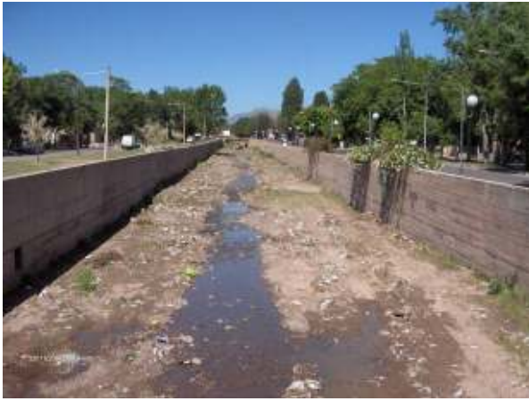
Figura 220: Tramo mixto típico, con los muros de hormigón de la década de 1970 y el fondo de terreno natural, con dientes de fondo para disminuir la pendiente de equilibrio. La imagen corresponde a una vista luego de la remoción de primavera de la vegetación y la basura que normalmente es arrojada al cauce.
