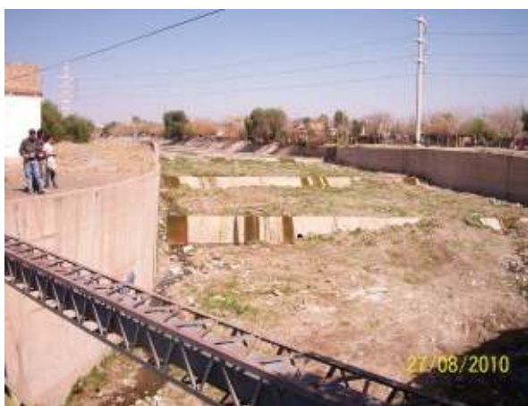
Figura 270: Embocadura del Zanjón de Los Ciruelos y finalización del Canal Papagayos luego de una campaña de limpieza y desmalezado
