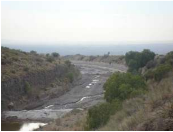
Figura 421: Cauce del Colector Las Heras a la salida del Arroyo El Challao, en el inicio de la curva hacia el norte. Al fondo puede verse la Ciudad de Las Heras a una cota topográfica muy inferior a la del cauce.
