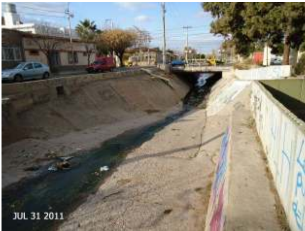
Figura 280: Transición de la sección rectangular a trapezoidal, en coincidencia con Av. General San Martín.
