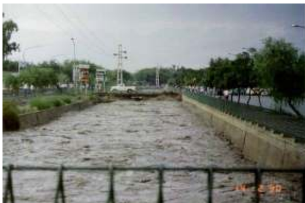
Figura 125: Crecida en el Cacimiento Guaymallén en el tramo aguas arriba del Dique Agarrobal. Puede verse la interferencia de la estructura del puente en el escurrimiento del torrente.
