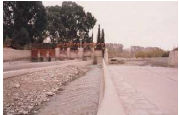
Figura 160: Dique Algarrobal hacia aguas arriba, vista de las distintas cámaras para los desripiadores.
