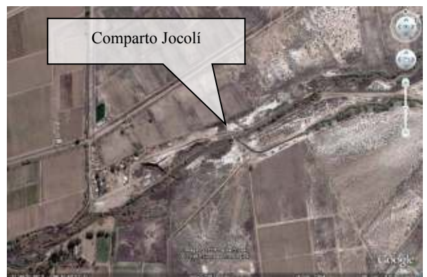
Figura 163: Finalización del Canal Cacique Guaymallén en la obra de derivación del Canal Jocolí y una hijuela sobre la margen derecha. Puede verificarse la característica meandrosa del cauce y los suelos salinos circundantes.
