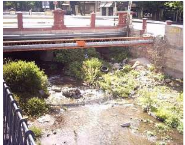
Figura 227: Vista del Puente de Avenida San Martín, previamente al revestimiento de las losas de fondo (Etapa I).
