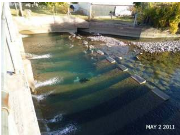
Figura 138: Cuenco amortiguador Dique Carrodilla
