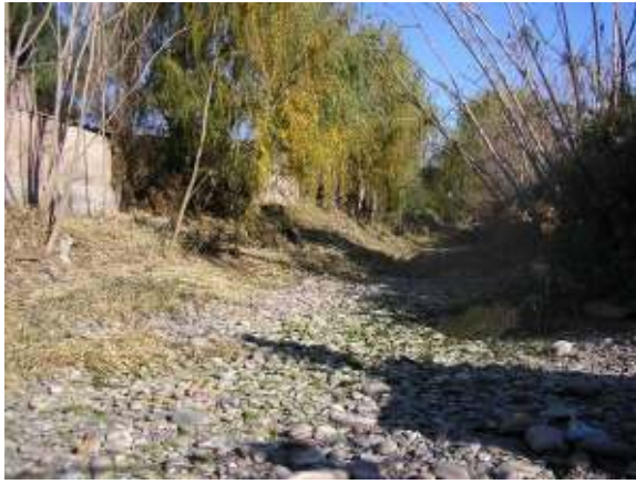
Figura 113: Estado del cauce en Calle Rivadavia previo a las obras de 2005, Departamento de Godoy Cruz.
