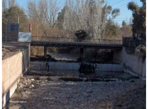
Figura 146: Puente y salto con cuenco disipador
