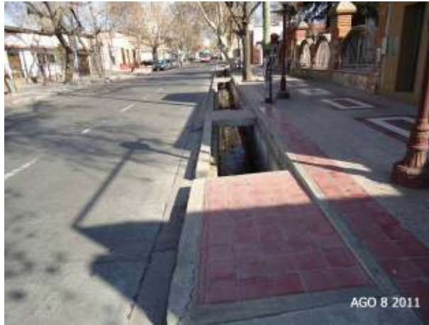
Figura 387: Aspecto característico de los colectores del Sistema de la plaza Godoy Cruz, son sección rectangular de 1m x 1m, en este caso, en Calle Antonio Tomba
