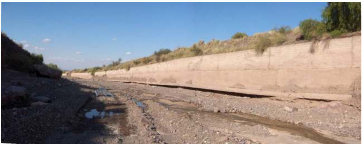
Figura 442: Vista completa del efecto de descalce y falla de los muros (al fondo)
