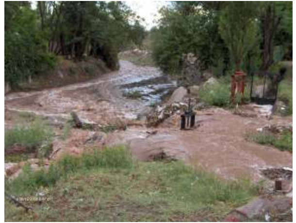
Figura 195: Curva hacia el norte (izquierda) del cauce. Fotografía luego de una tormenta, que saturó la hijuela de riego Chacras de Coria, produciendo el desborde controlado hacia el cauce del río seco. La limpieza de la hijuela se realiza de la misma manera, accionando el conjunto de compuertas de la figura, arrojando hidráulicamente todos los desperdicios al cauce.
