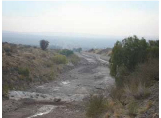
Figura 422: Imagen del tramo del Colector Las Heras aguas arriba del triple salto. El colector se encuentra excavado, con la margen derecha compuesta por un muro de hormigón y terraplén de protección. La margen izquierda se encuentra en terreno natural, captando todos los aportes de la hidrografía natural de la Precordillera.
