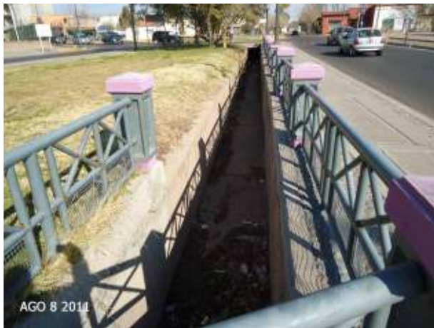
Figura 387: Aspecto característico de los colectores del Sistema de la plaza Godoy Cruz, son sección rectangular de 1m x 1m, en este caso, en Calle Antonio Tomba
