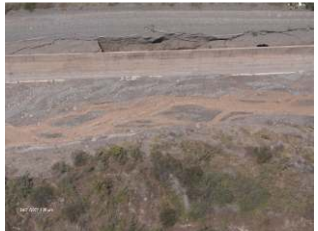
Figura 69: Sifonaje del Azud San Isidro luego de la crecida del 24 de enero de 2007
