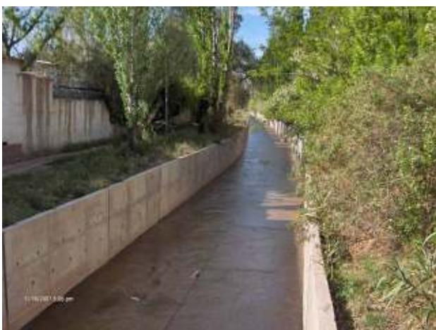
Figura 179: Sección revestida del Río Seco Viamonte entre calle Malvinas y Ugarte
