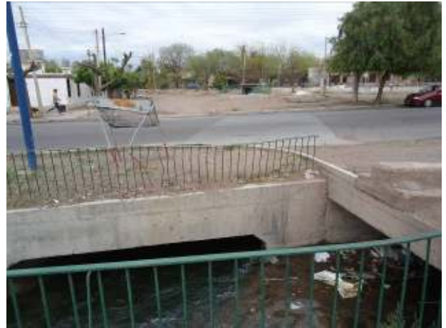
Figura 325: Confluencia del Canal Jarillal con el Gorriti. Al fondo, el edificio de compuertas.
