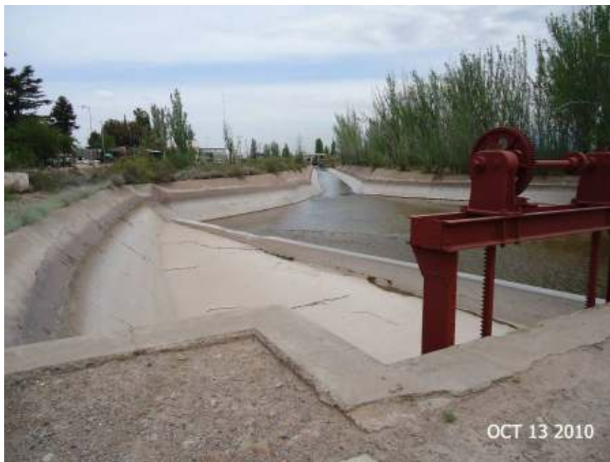
Figura 129: Cauce Canal Cacique Guaymallén aguas abajo del Gran Comparto. Dársena de entrada a la aducción de la Central Hidroeléctrica Lujanita
