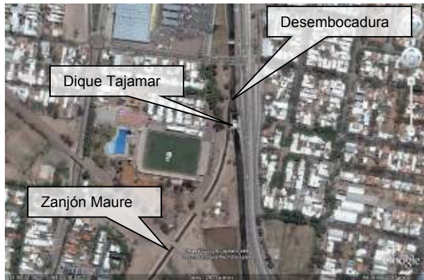
Figura 149: Desembocadura del Zanjón Maure aguas abajo del Dique Tajamar. El cauce del Maure experimenta una amplia curva antes de incorporarse al Canal Cacique Guaymallén, de manera tangencial al mismo.
