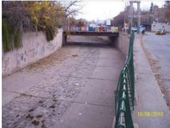
Figura 245: Inicio del tramo totalmente revestido, con la solera central empedrada para resistir los efectos de la erosión principal de fondo
