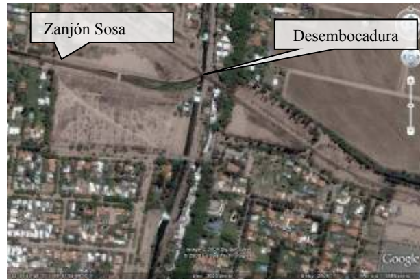
Figura 131: Desembocadura del Zanjón Sosa, angulado respecto de la alineación general del Canal Caci que Guaymallén. 200 metros al sur, puede verse el puente de Calle Pueyrredón, equidistante con el Dique Gil, otros 200 metros más al sur.
