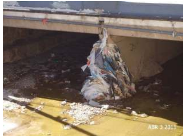
Figura 229: Detalle de la acumulación de los RSU acumulados en la pila central del puente de calle San Martín.
