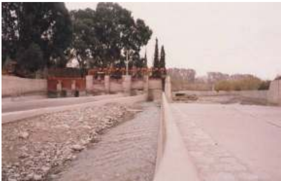
Figura 159: Edificio de compuertas del Dique Algarrobal y aliviadero de margen derecha
