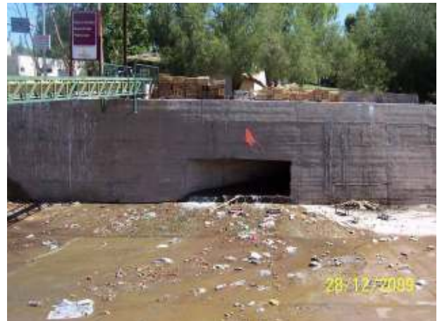
Figura 335: detalle de la desembocadura del Colector Gorriti y los RSU asociados.
