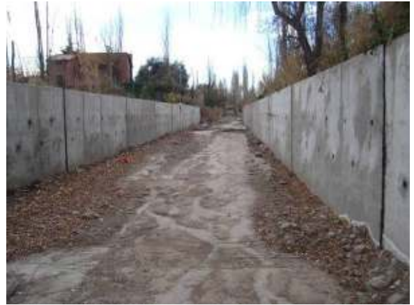
Figura 172: Sección de hormigón armado rectangular aguas debajo de calle Orsini. Al Fondo, el puente de Calle Malvinas – Matheu.
