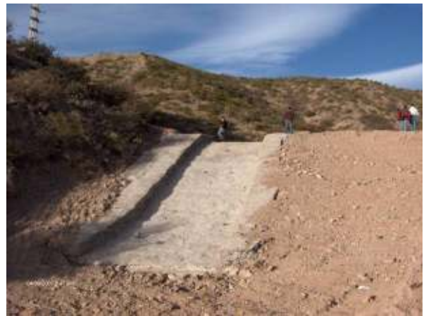
Figura 454: Obra en fase terminal
