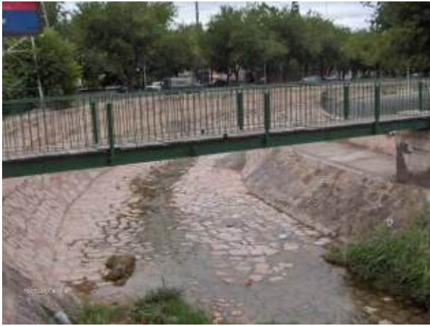
Figura 257: Curva hacia el este, retomando la alineación oeste – este original. Pueden observarse las distintas etapas de revestimiento del cauce. La primera corresponde a la solera y los taludes 1:1 inclinados. La segunda y definitiva, corresponde a los sectores de muros de hormigón verticales.
