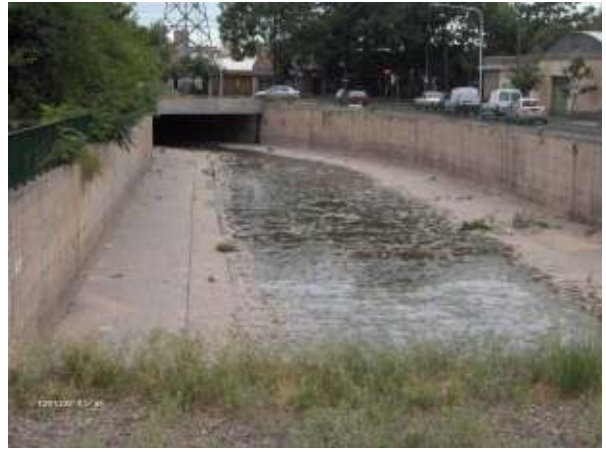
Figura 254: Cambio de dirección hacia el norte, visto desde el puente del ferrocarril. Parte de la curva queda bajo el puente de la calle Belgrano. La sección posee un sector central empedrado para mitigar los efectos de la erosión de fondo.
