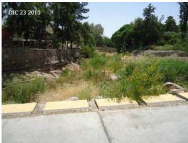
Figura 416: Vista hacia aguas abajo del badén.
