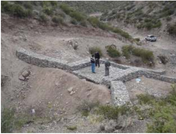
Figura 452: Imágenes de una retención típica durante el período de construcción, donde puede observarse el geotextil bajo el vertedero, su estructura de alambre y piedra y la rápida de salida.
