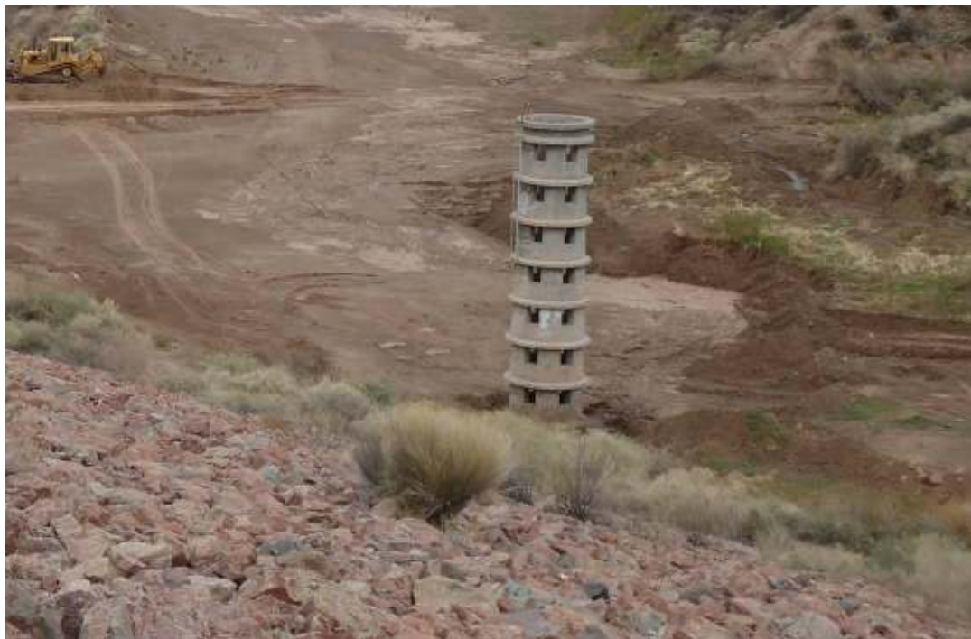
Figura 51: Detalle de la torreta de descarga y material del espaldón aguas arriba
