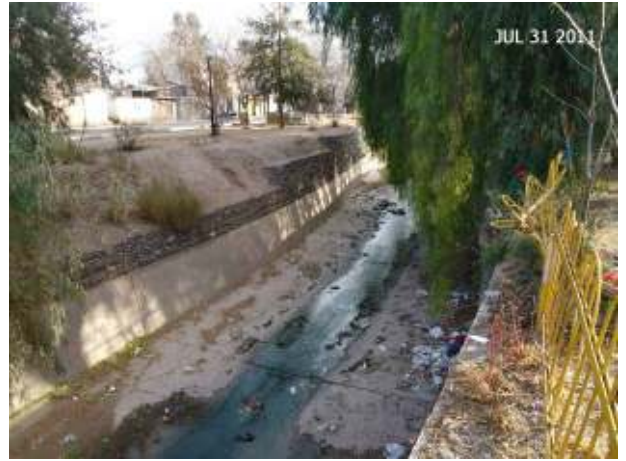
Figura 276: Sección transversal del Zanjón de Los Ciruelos de 5 m de profundidad cercano aguas arriba de calle Perú. Las márgenes se encuentran reforzadas con gaviones.
