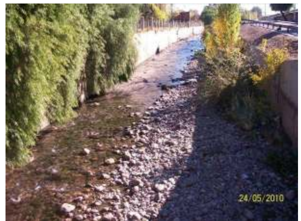
Figura 152: Sección mixta, donde el fondo conserva la configuración típica de grava gruesa
