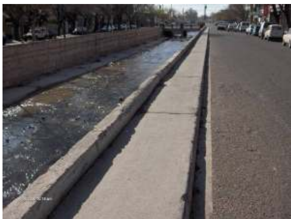
Figura 224: Revestimiento completo del cauce aguas arriba de la Calle San Martín, principal arteria de la ciudad de Godoy Cruz.
