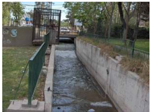
Figura 329: Vista hacia aguas arriba de la obra de control
