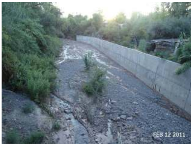
Figura 418: Protección de margen izquierda, vista desde el puente de Maristas, hacia aguas arriba.
