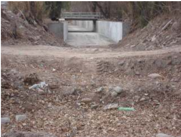
Figura 169: Transición entre la sección de suelo natural y la sección de hormigón armado. Al fondo, el puente de Calle Orsini.
