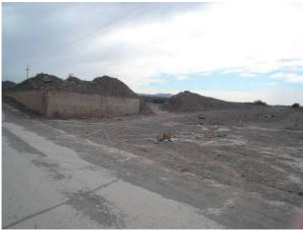
Figura 427: Vista del badén de la Ruta Provincial N°13. Puede verse el canal de alivio sobre la margen izquierda para desaguar hacia el bajo de la quebrada de Las Chilcas, que ofrece una capacidad adicional de retención y laminación previa a Campo Espejo
