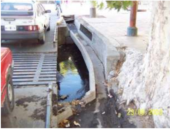
Figura 369: Sistema de captación de agua pluvial en la intersección de Avenida San Martín y Zanjón Frías. Puede observarse el cauce de la acequia que conserva una pequeña sección para conducir el agua de riego.
