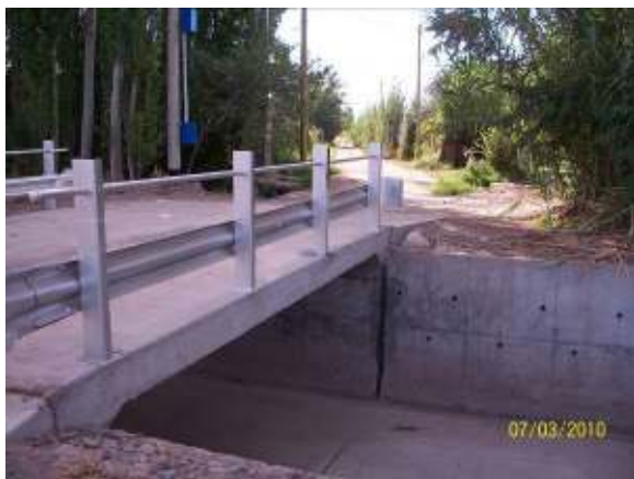
Figura 177: Puente que reemplazó a un badén que servía a 12 familias que se veía aisladas por las crecidas
