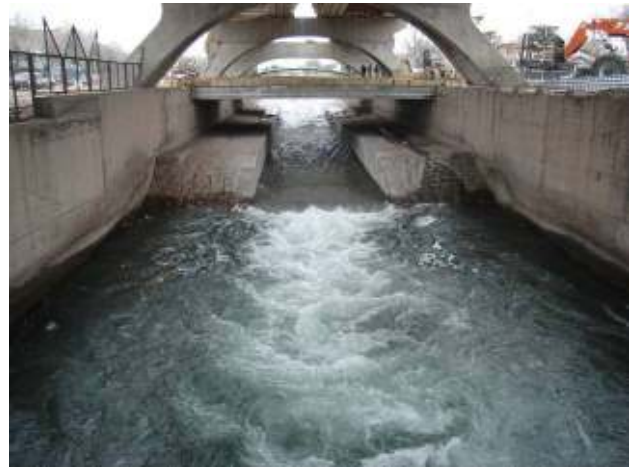
Figura 156: Obra en régimen con las dotaciones normales de riego.
