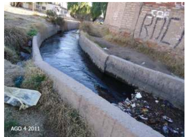
Figura 351: Vista hacia aguas abajo del Canal Civit a la salida del sifón. El tramo revestido es de solamente unos pocos metros.
