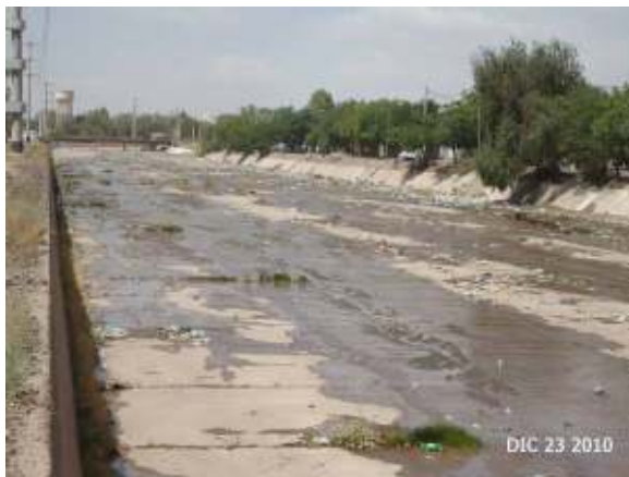
Figura 268: Tramo trapecial en dirección norte
