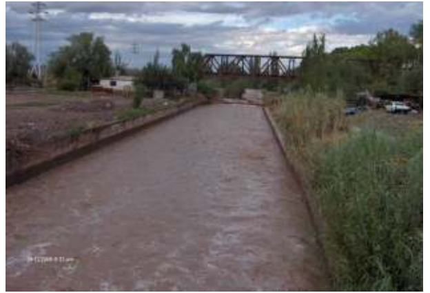
Figura 108: Cauce Canal Caci que Guaymallén aguas arriba de la desembocadura del Zanjón Sosa.
