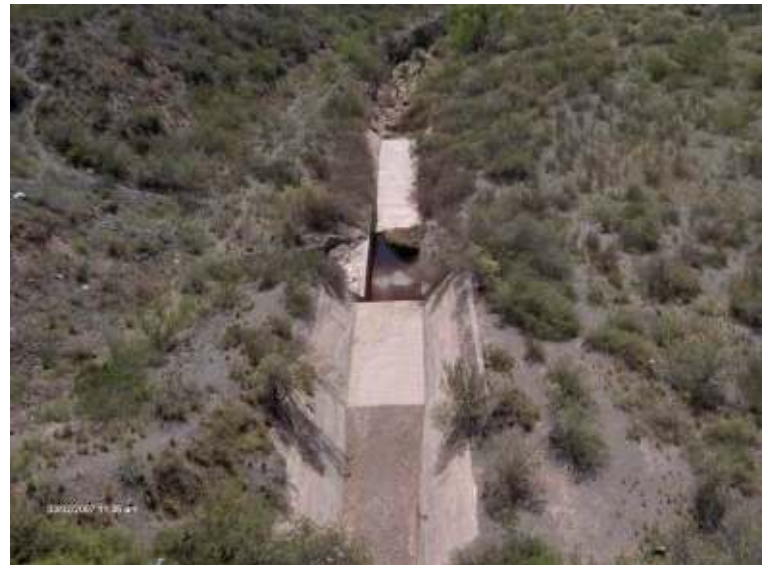
Figura 63: Fotografías del canal de evacuación de una de las torretas de la descarga de fondo, en funcionamiento y en reposo
