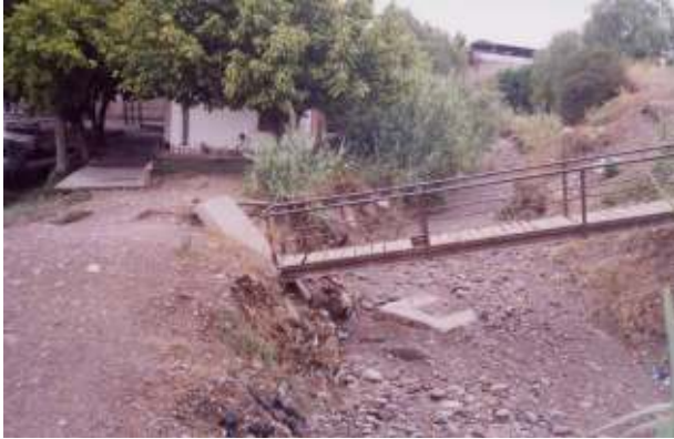
Figura 296: Estado del cauce de la Hijuela Chacras de Coria previo a su revestimiento.
