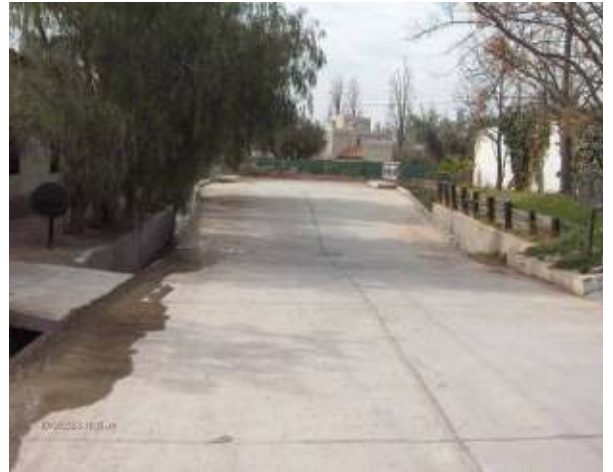
Figura 184: Calle Canal Malvinas, en desembocadura en el Río Seco Viamonte.
