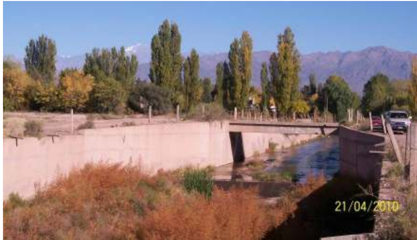
Figura 133: Sección del Zanjón Sosa previa a la desembocadura en el Canal Cacique Guaymallén, vista hacia aguas arriba.
