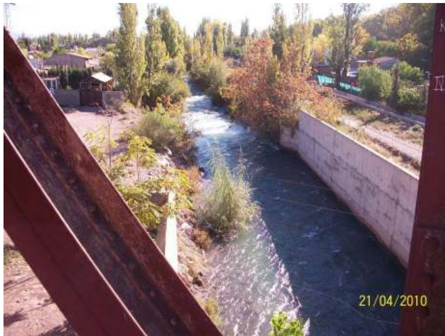
Figura 134: Sección del Canal Cacique Guaymallén, vista hacia aguas abajo de la desembocadura del Zanjón Sosa.
