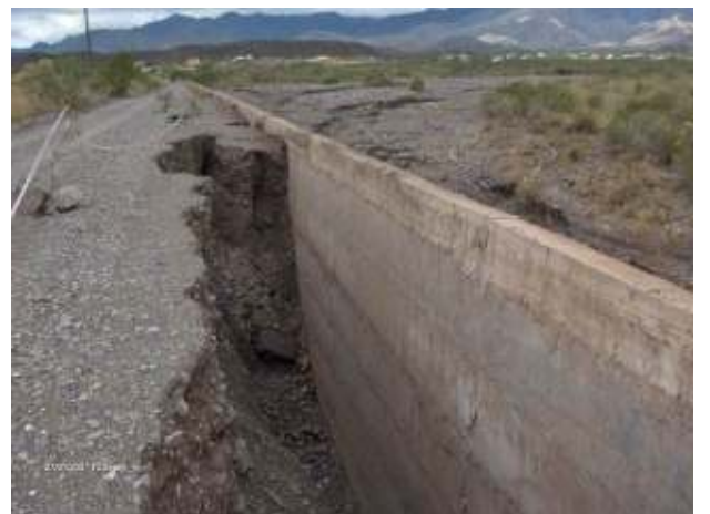
Figura 69: Sifonaje del Azud San Isidro luego de la crecida del 24 de enero de 2007
