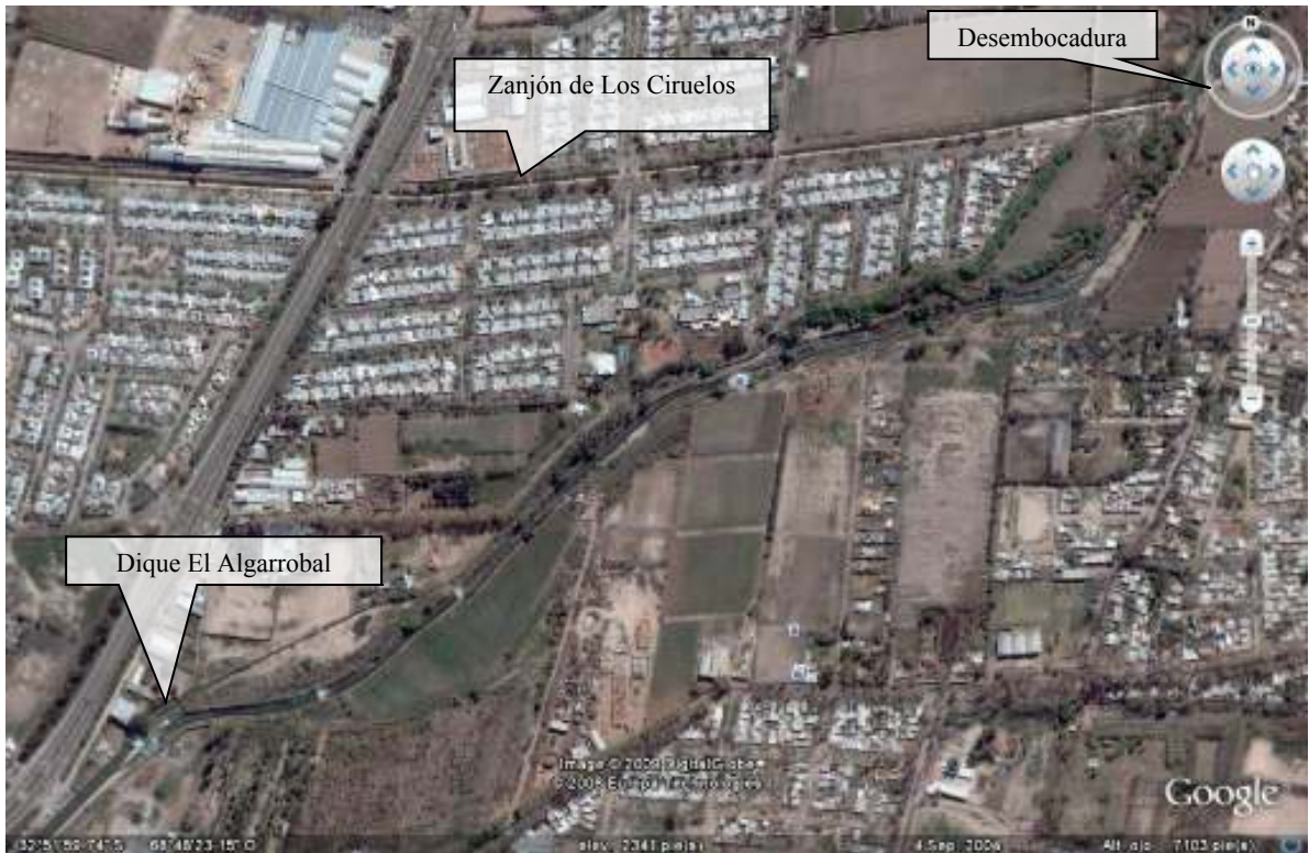
Figura 161: Vista general de la desembocadura del Zanjón de los ciruelos en el Cacique Guaymallén aguas abajo del Dique Algarrobal. El cauce deja su fisonomía urbana para transformarse nuevamente en un cauce en terreno natural con numerosos meandros y altas barrancas.
