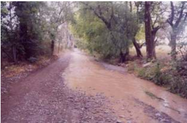
Figura 402: Calle Almirante G. Brown, luego de una descarga aluvional, la cual ha arrastrado el material estabilizado, dejando solamente las piedras más grandes.
