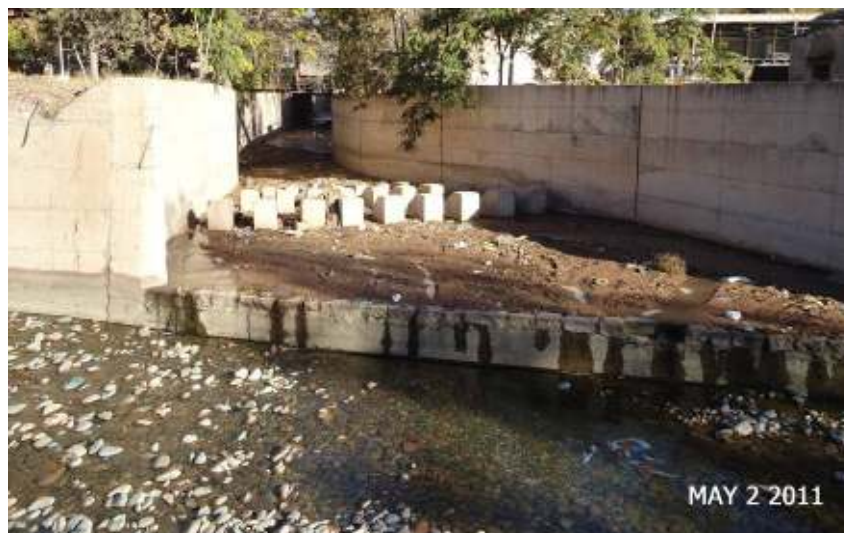
Figura 141: Desembocadura del Río Seco Liniers a través de una obra de disipación de energía, formada por tres filas de dados y un salto de 70 cm.
