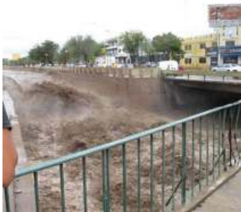
Figura 127: Crecida Aluvional sobre el Canal Cacimiento Guaymallén en la progresiva correspondiente a la desembocadura del Zanjón Frías
