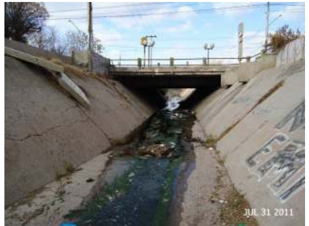
Figura 281: Sección trapezoidal bajo calle San Martín.
