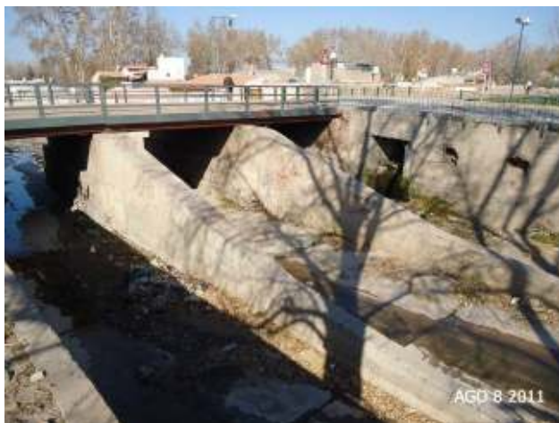
Figura 390: Desembocadura de uno de los colectores Mosconi, en la zona de vías en Godoy Cruz, directamente el Zanjón Maure.
