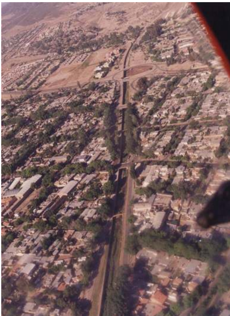
Figura 215: Vista aérea del Cauce del Zanjón Maure, donde puede verse desde la desembocadura del Colector Los Cerrillos hasta el Barrio Bancario.
