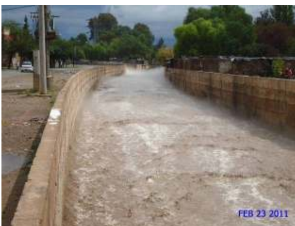
Figura 213: Crecida aluvional en el Zanjón Maure, con exclusivo aporte desde el Colector Los Cerrillos.
