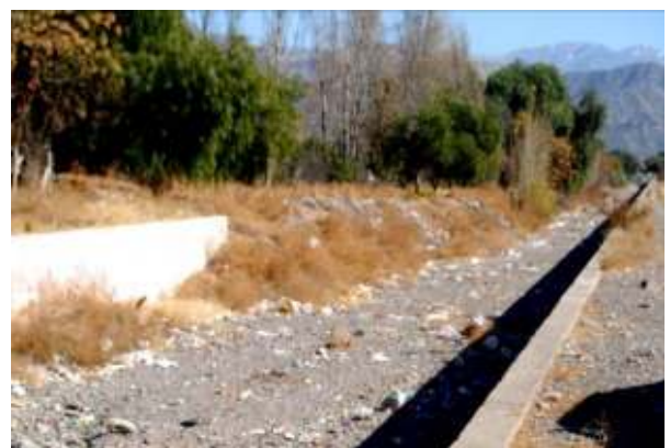
Figura 355: Vista representativa del Colector Infanta, donde el muro principal se encuentra a la derecha de la fotografía, mirando hacia aguas arriba, es decir, hacia el oeste.
