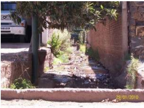
Figura 402: Calle Almirante G. Brown, luego de una descarga aluvional, la cual ha arrastrado el material estabilizado, dejando solamente las piedras más grandes.
