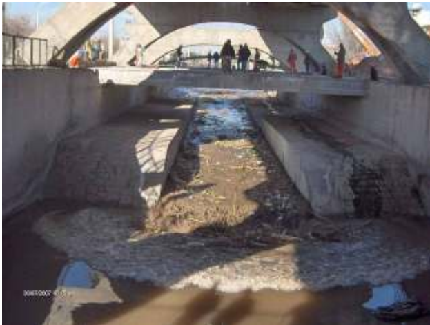
Figura 155: Obra terminada, llegada del primer golpe de agua
