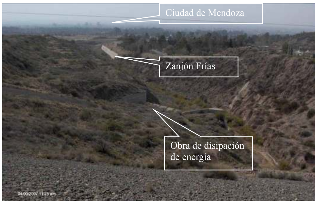
Figura 55: Fotografía de la obra de disipación de energía y la Ciudad de Mendoza como fondo.
