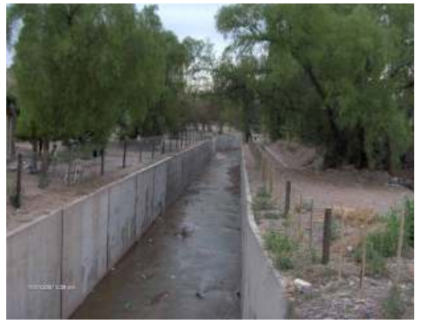
Figura 187: Revestimiento del Río Seco Viamonte aguas debajo de ruta Panamericana. Al fondo, su desvío hacia el este para transformarse en el Río Seco Liniers.
