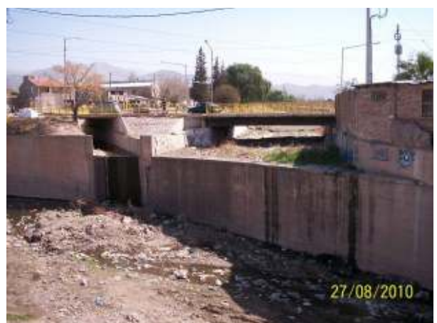
Figura 271: Desembocadura del Colector Infanta y del desagüe interno de los barrios del oeste de Capital sobre la embocadura de la traza del Zanjón de Los Ciruelos
