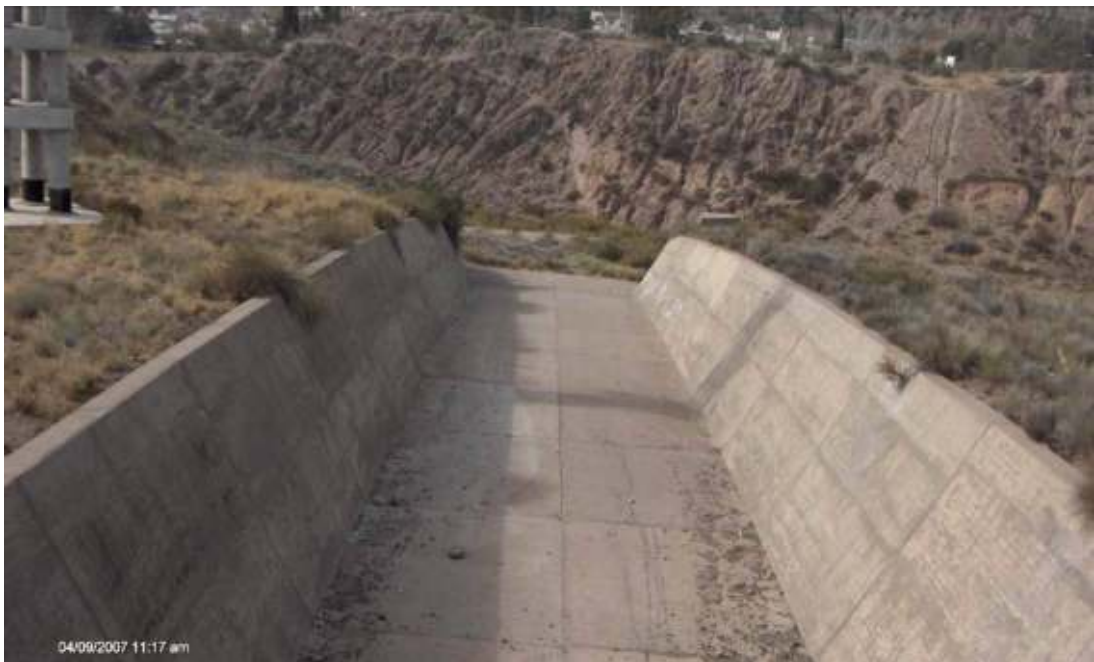
Figura 53: Rápida de evacuación del Aliviadero de margen izquierda
