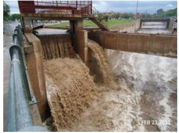
Figura 217: Descarga al Zanjón Maure durante una crecida aluvional, la que encontró a la compuerta baja, a pesar de la tormenta y las previsiones del radar meteorológico.
