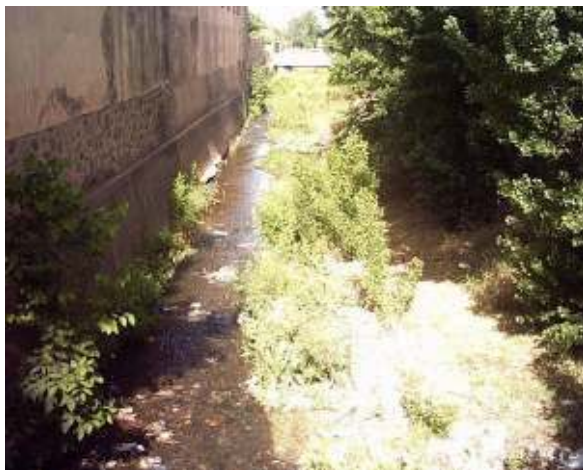
Figura 230: Vista del cauce aguas abajo de calle Belgrano, previamente a las obras de construcción de margen derecha y losas de fondo (Etapa III).
