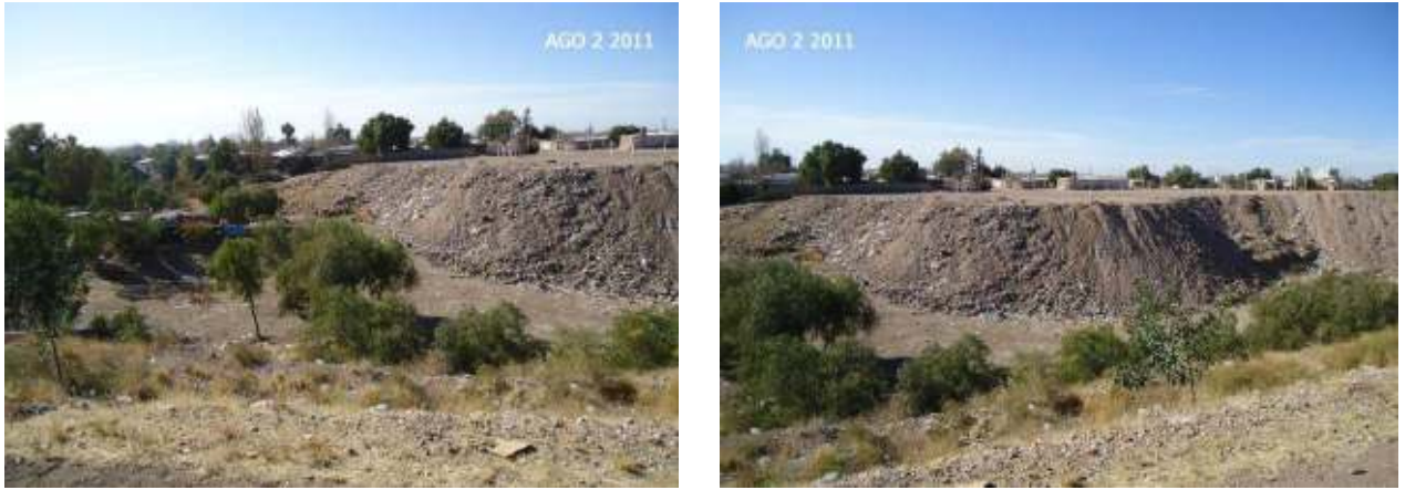
Figura 311: estado del vaso destinado a retener los excedentes hídricos del barrio La Estanzuela, ocupado parcialmente por una gran montaña de escombros.
