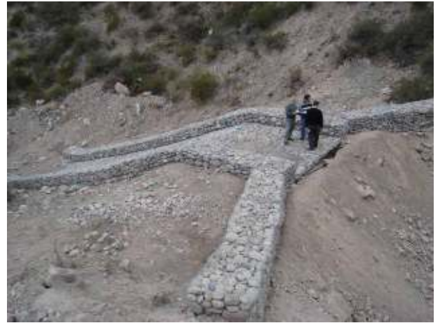
Figura 452: Imágenes de una retención típica durante el período de construcción, donde puede observarse el geotextil bajo el vertedero, su estructura de alambre y piedra y la rápida de salida.
