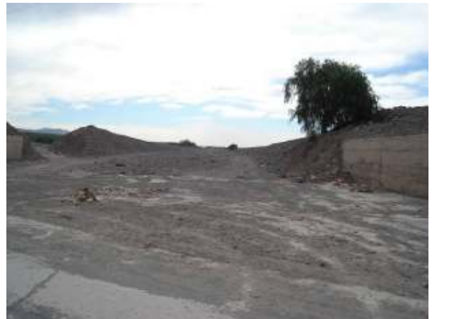
Figura 428: Panorama general del cauce en su tramo hacia el norte sin revestir, donde la margen derecha se encuentra conformada por un amplio terraplén.
