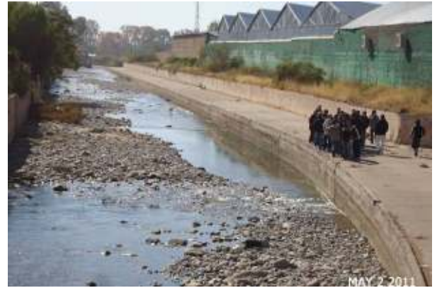
Figura 158: Sección de aproximación al Dique Algarrobal, cuyo aliviadero se abre sobre la margen derecha
