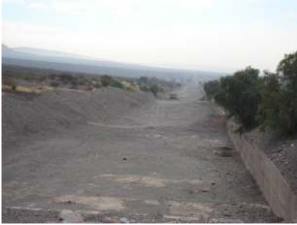
Figura 425: Vista hacia aguas abajo del triple salto, en dirección norte.
