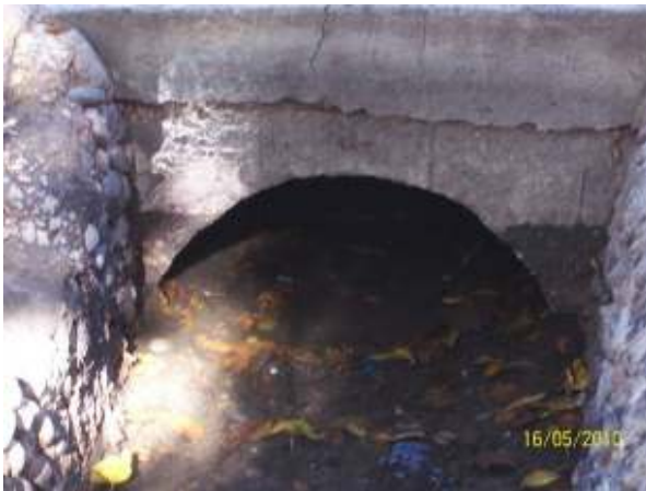
Figura 369: Sistema de captación de agua pluvial en la intersección de Avenida San Martín y Zanjón Frías. Puede observarse el cauce de la acequia que conserva una pequeña sección para conducir el agua de riego.
