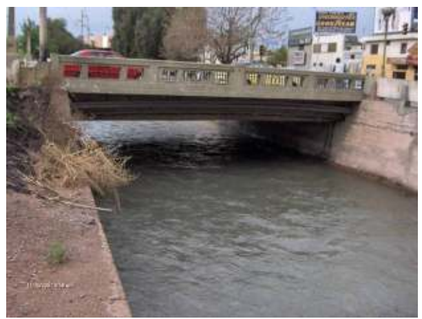
Figura 122: Vista del Puente Brasil, límite entre Godoy Cruz y Capital.
