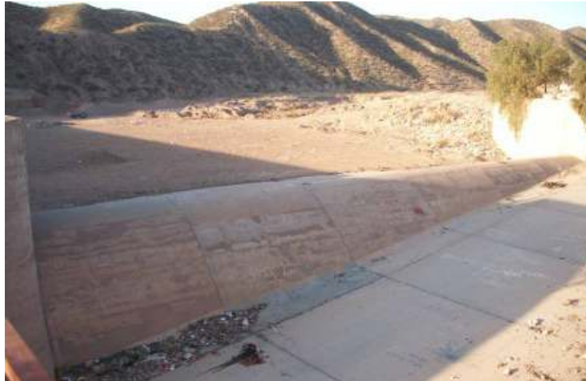
Figura 34: Vista del Vertedero del Aliviadero sobre margen izquierda
