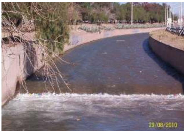
Figura 151: Sección totalmente revestida frente al Jumbo, transportando la dotación de riego.
