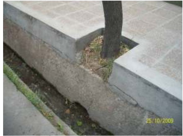
Figura 364: Especie plantada a nivel de la vereda, con una apertura en el fondo de la acequia. Puede verse que la margen interna de la acequia comienza a ser afectada por el crecimiento radicular. Ello provocará un estrangulamiento de la acequia con el tiempo.
