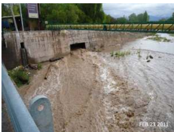
Figura 240: Descarga aluvional del Gorriti sobre el Zanjón Frías, luego de una tormenta convectivas precipitada en el oeste de Godoy Cruz.
