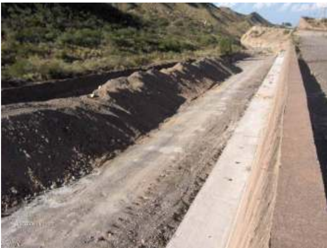
Figura 80: Recalce del pie del Azud San Isidro.
