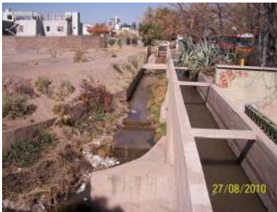
Figura 272: Descargador del Canal Jarillal al Zanjón de Los Ciruelos
