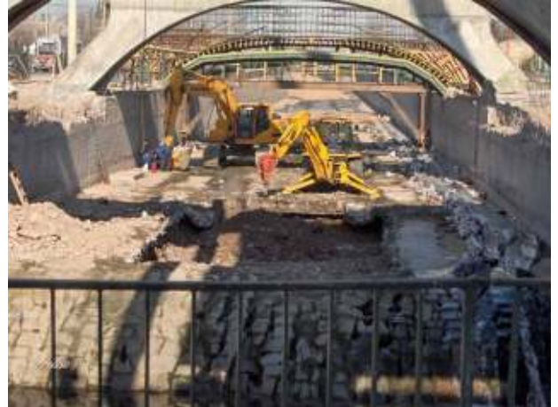
Figura 154: Obra de profundización del sector central de la canalización principal.
