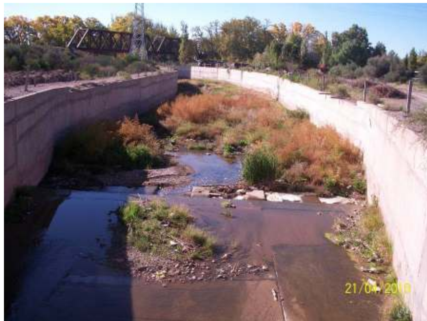
Figura 132: Sección del Zanjón Sosa previa a la desembocadura en el Canal Caci que Guaymallén.
