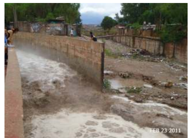
Figura 214: Detalle de la desembocadura y del exclusivo aporte desde el Colector Los Cerrillos, sin escurrimiento desde aguas arriba del cauce principal.
