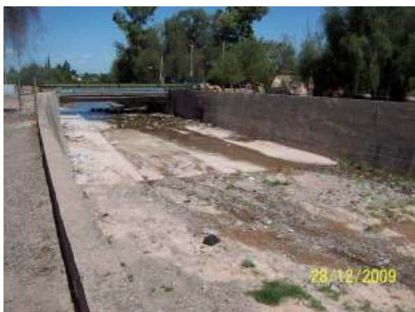
Figura 237: Desembocadura del Colector Gorriti en el tramo de solera de hormigón ejecutado en el año 2009.
