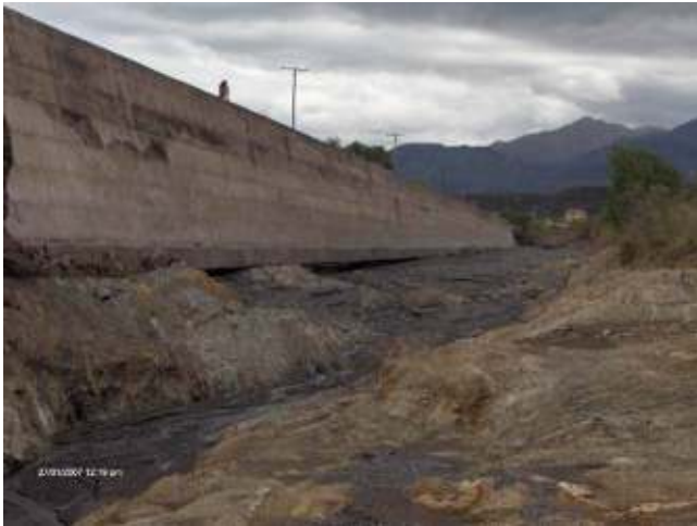
Figura 72: Erosión regresiva bajo los muros del Azud
