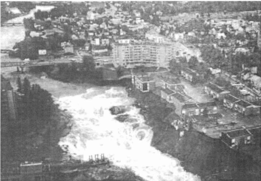
Figura N° 4: Erosión fluvial y deslizamientos de tierra en Jonquière. Fuente: Ministère des Transports (1999).
