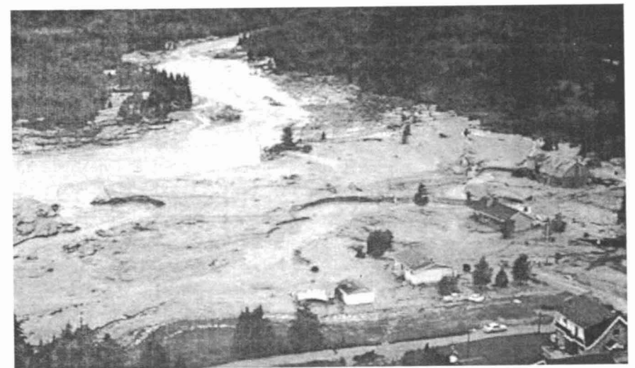
Figura N° 5: Acumulación de sedimentos en los sectores de suave pendiente en el río Ha!Ha!. Fuente: Ressources naturelles Canada (2010).
