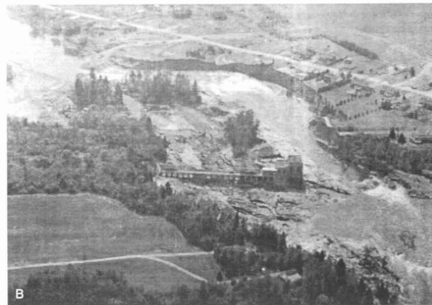
Figura N° 2: La región de la presa Pont Arnaud, antes (figura A) y después (figura B) del desbordamiento de las aguas del río Chicoutimi. Fuente: Ministère des Transports (1999).
