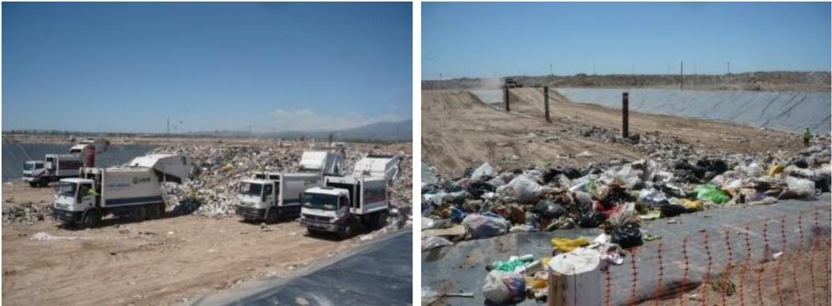
**Figura 13: Relleno de Celda**
