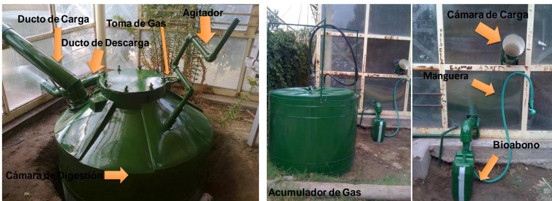
Figura 16: Biodigestor construido en escuela Moses J. Chade. Acumulador de gas, cámara de carga y descarga de Biodigestor.
