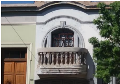
Abertura en forma circular. Calle Entre Ríos 233, Ciudad de Mendoza
