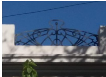
Herrería en coronamiento de edificio, Montecaseros 1436, Ciudad de Mendoza.
