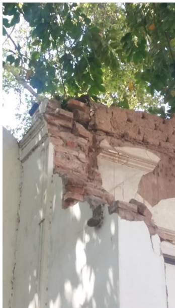
Detalle constructivo de fachada en ladrillo y muros de adobe, en vivienda de calle San Luis 440, Ciudad de Mendoza (demolida)
