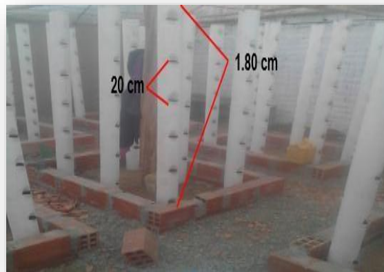
Figura 1. Instalación de contenedores verticales
