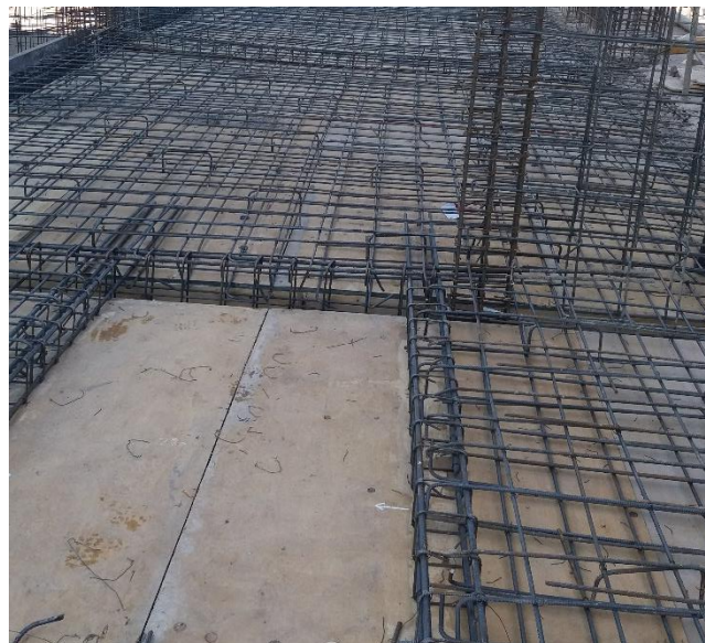
Ilustración 16: Losas Hospital Central.
