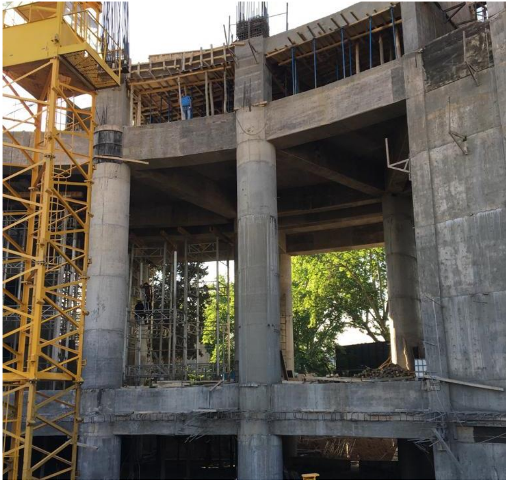
Ilustración 19: Vista Este Torre Leloir.
