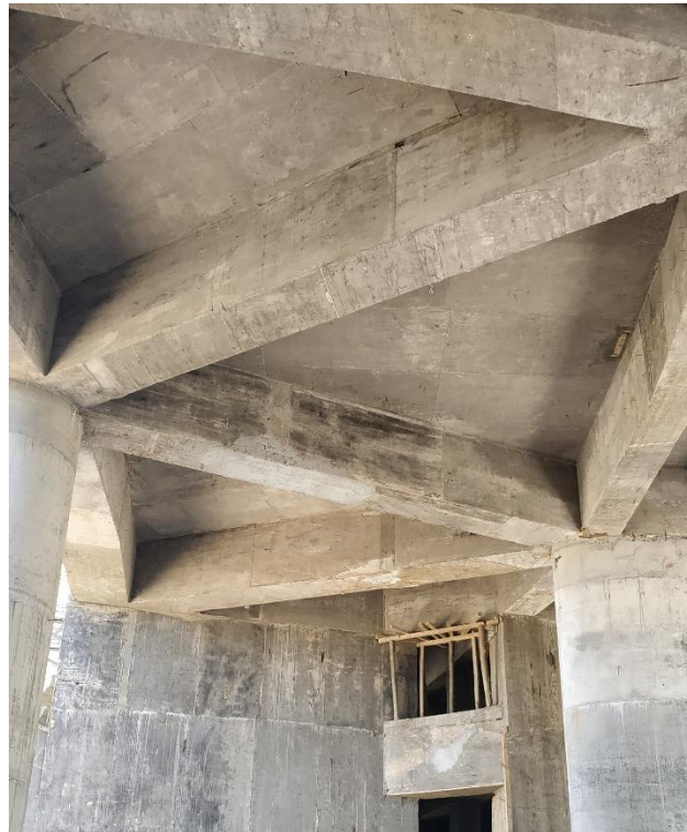
Ilustración 18: Vigas de 1,50m hormigonadas. Torre Leoir.
