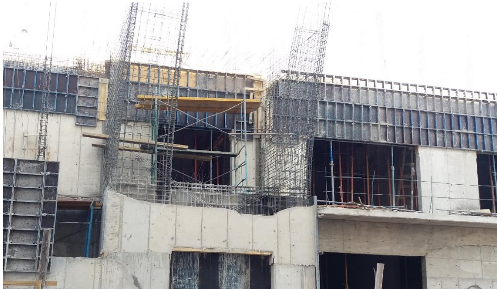
Ilustración 15: Tabiques Hospital Central.
