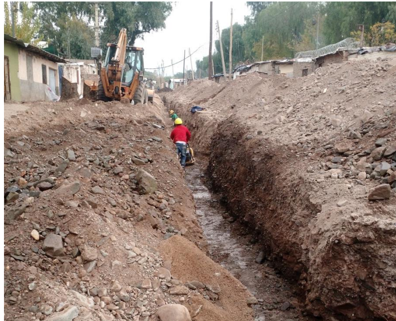
Figura 26 – compactación de la red cloacal
