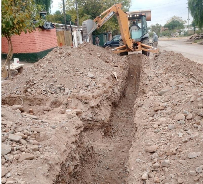
Figura 28 – excavación de la red de agua.
