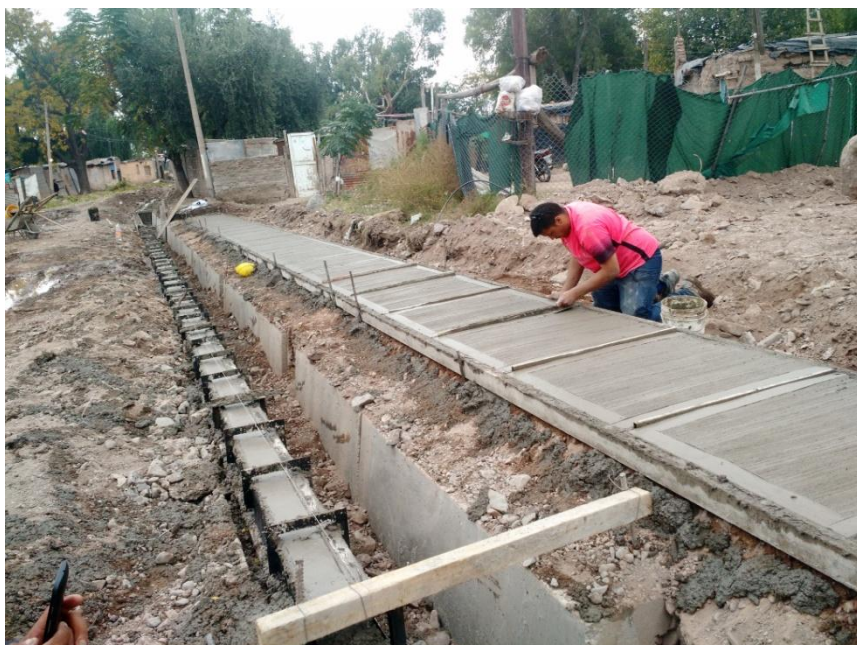
Figura 16 – realización de juntas y terminaciones
