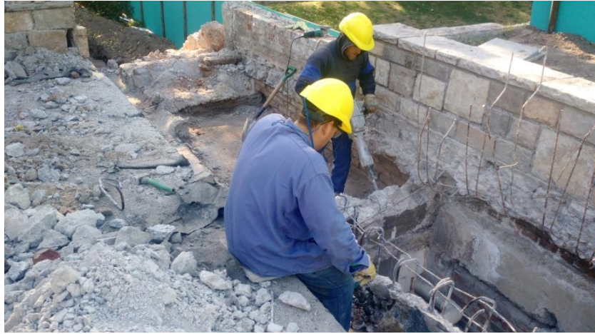
Figura 45 –levantamiento de la losa y paredes para la realización del desagüe y rampa
