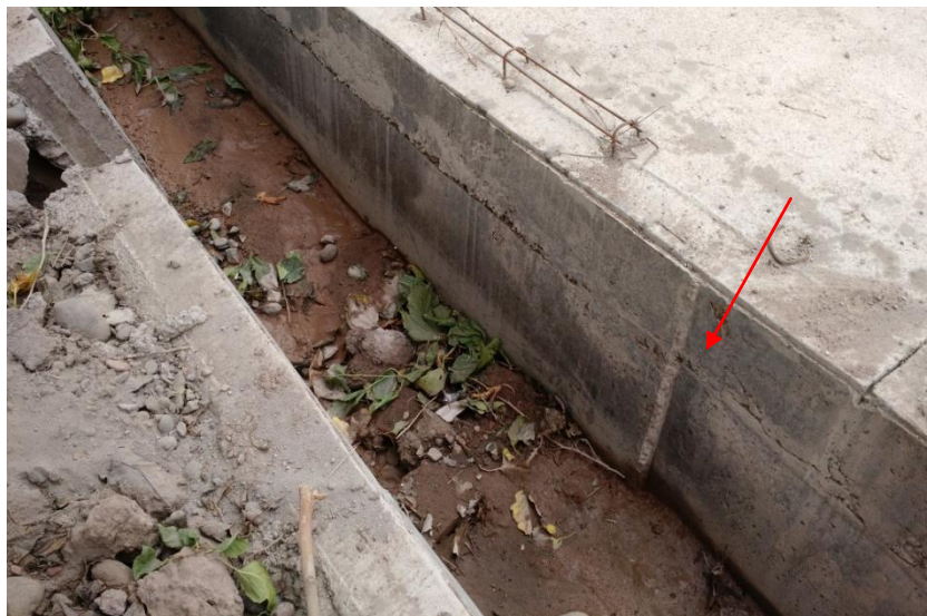
Figura 40 –Corrimiento del molde.
