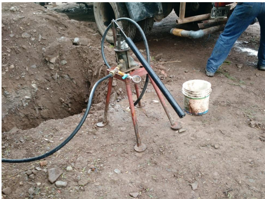
Figura 33 – Maquina para la realización de la prueba hidráulica.
