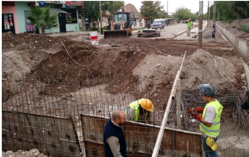
Figura 39 –Realización del puente canal
