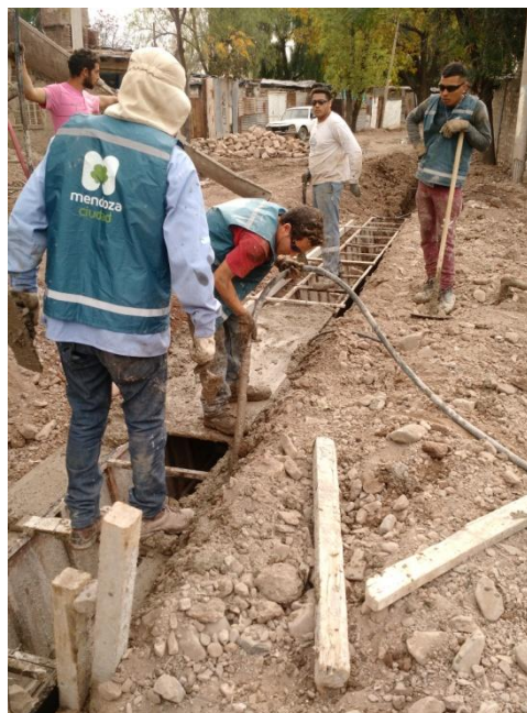
Figura 10 – llenado de cuneta.
