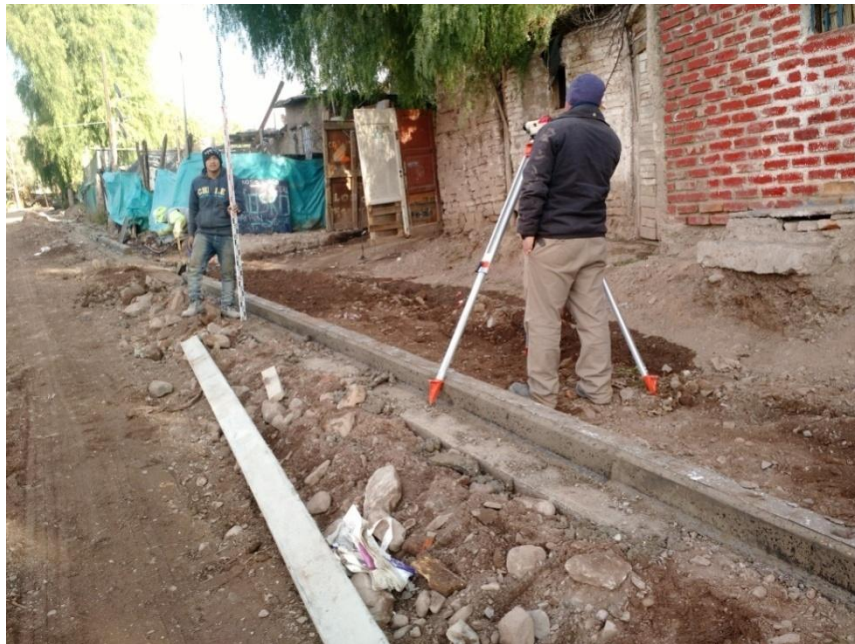
Figura 5 – toma de nivel de vereda
