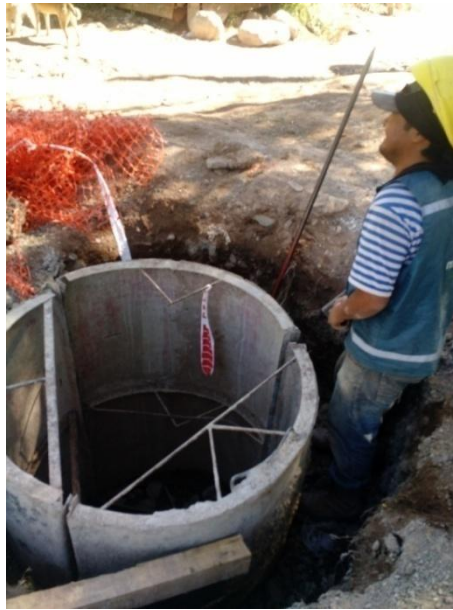
Figura 19 – moldeo de la boca de registro
