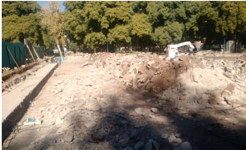
Figura 46 –levantamiento de la losa.
