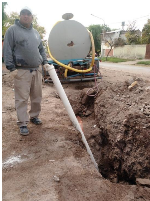
Figura 27 – llenado de la cañería
