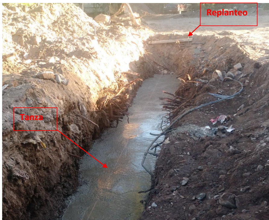
Figura 8 – llenado, niveles de fondo de cuneta y replanteo.
