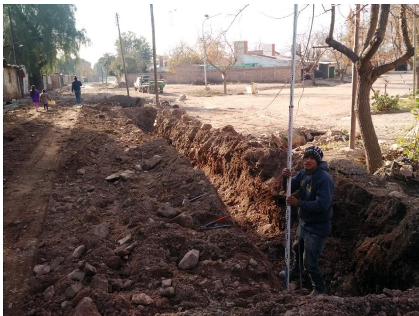
Figura 6 – toma de nivel de fondo de cuneta
