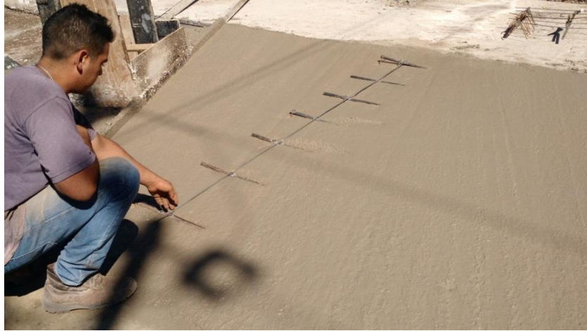
Figura 36 –Colocación de pasadores
