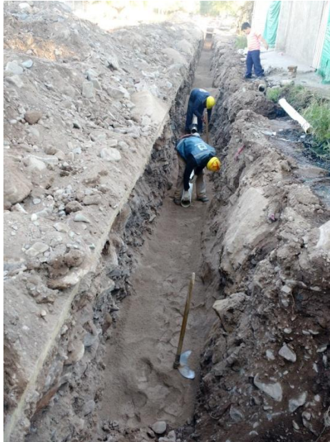
Figura 24 – marcado del sondeo
