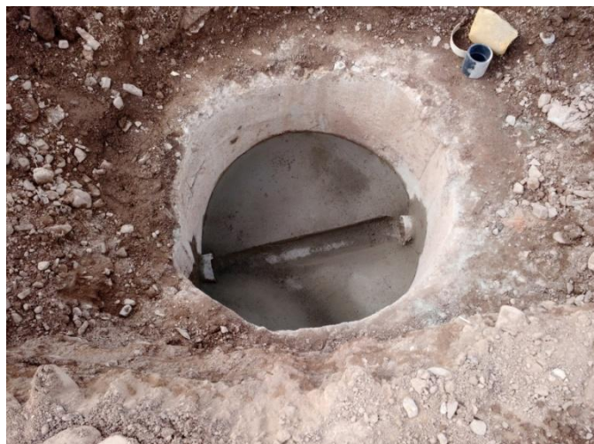
Figura 21 – Realización del cojinete
