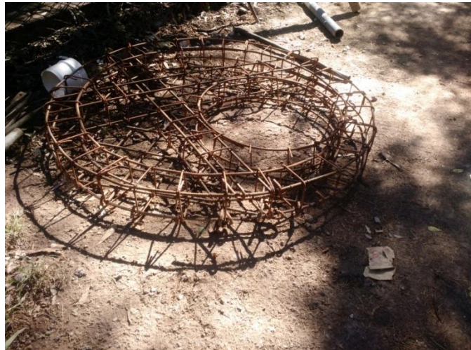
Figura 20 – verificación de armadura
