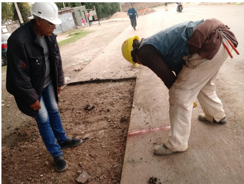
Figura 23 – marcado del sondeo
