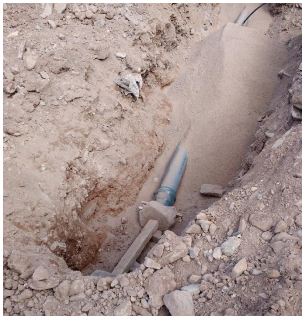
Figura 31 – colocación del tapón para la prueba hidráulica
