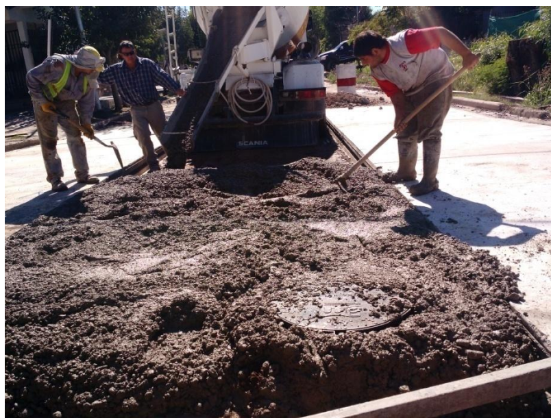
Figura 35 –Llenado de hormigón.
