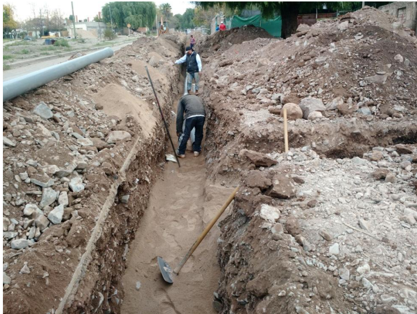
Figura 30 – tendido de la arena
