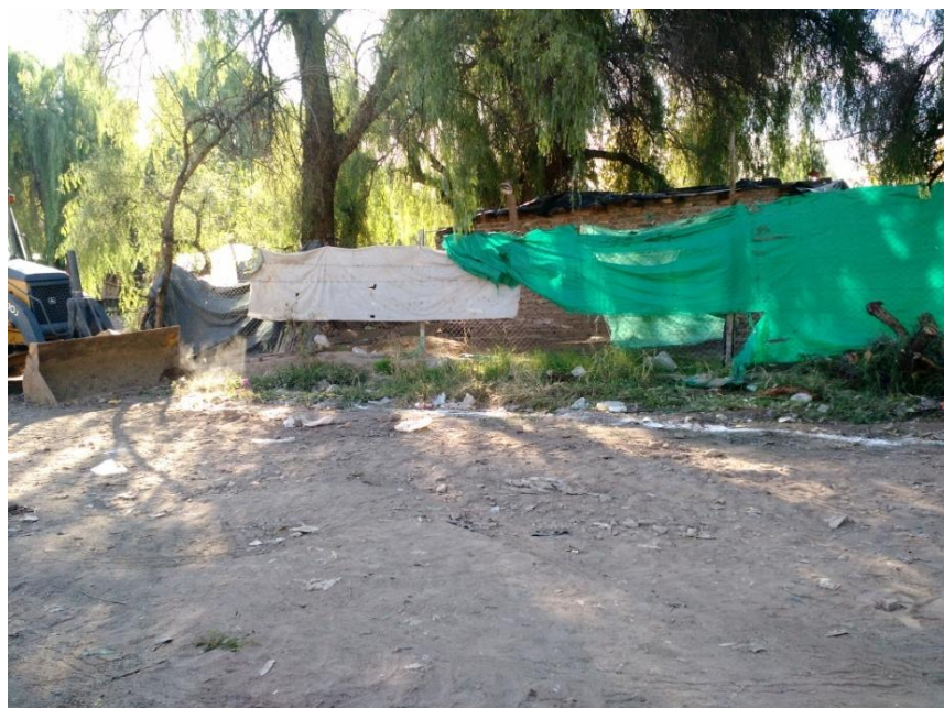
Figura 4 - marcación de eje de cuneta
