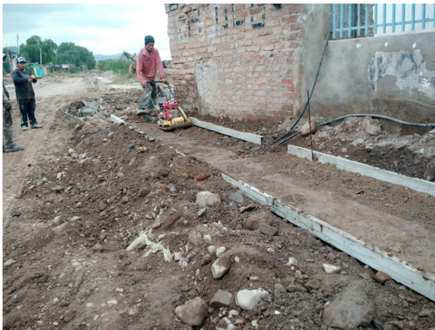
Figura 14 – compactación de la vereda.
