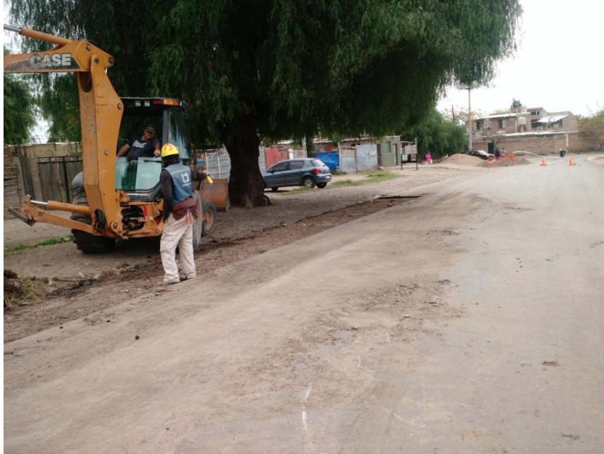
Figura 22 – excavación de la red cloacal
