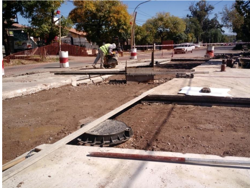
Figura 34 – preparación para el llenado de hormigón.
