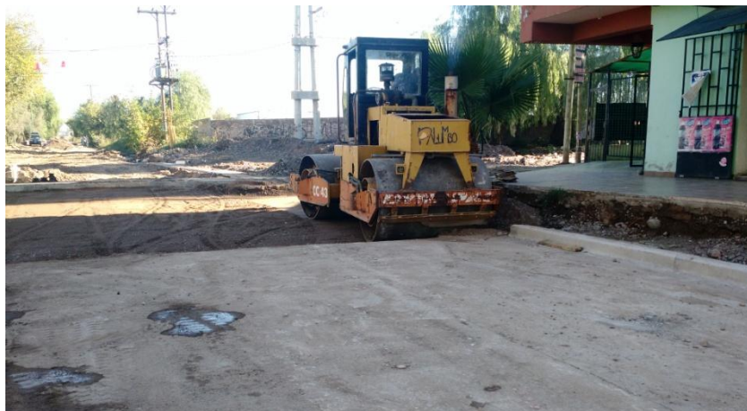
Figura 43 – Compactación del suelo.
