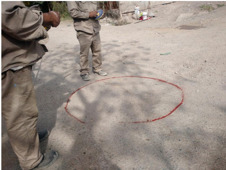
Figura 17 – Marcación de la boca de registro
