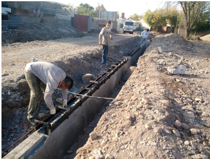
Figura 12 – toma de linealidad y moldeo del cordón.
