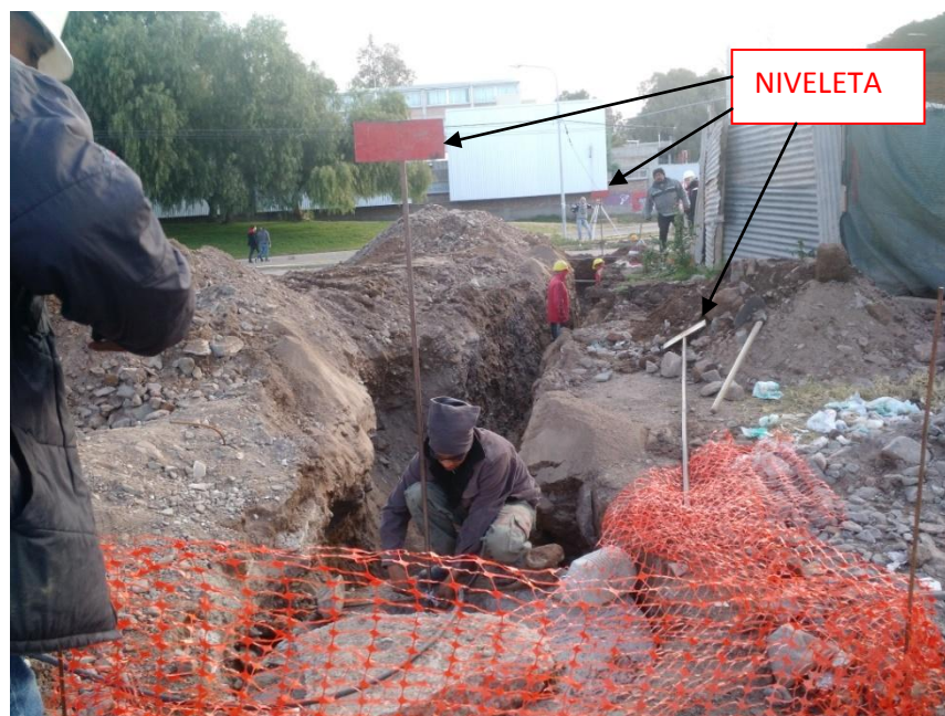
Figura 25 – verificación de los niveles
