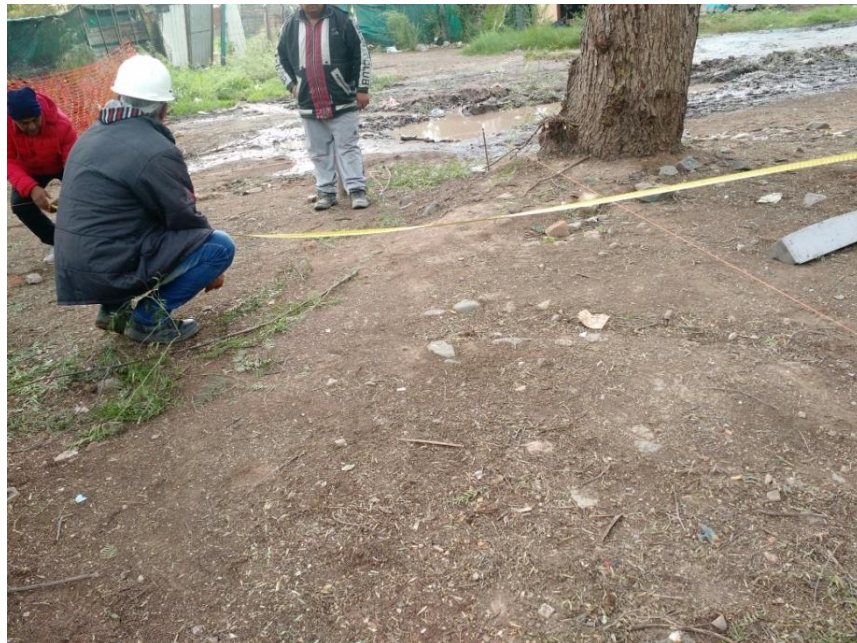
Figura 3 - replanteo eje de calle
