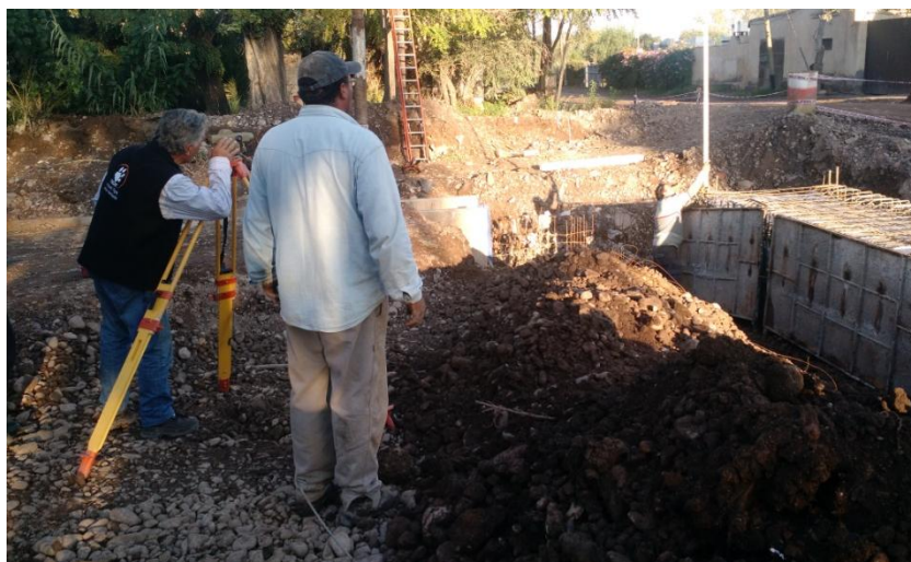
Figura 41 –Toma de niveles del puente.
