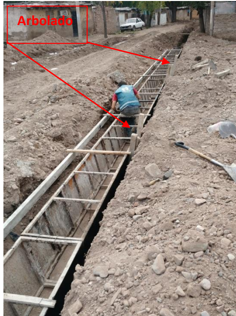
Figura 9 – moldeo de cunetas.
