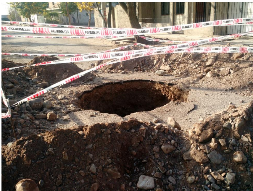
Figura 18 – Realización de la boca de registro
