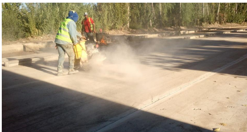
Figura 44 – Aserrado de la junta del hormigón
