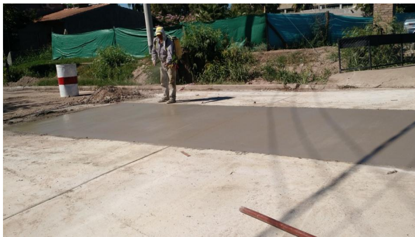
Figura 37 –Curado del hormigón
