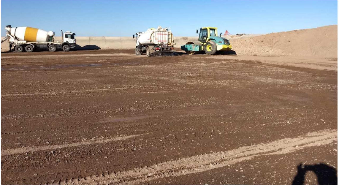
Figura 27. Trabajos en Pileta YPF
