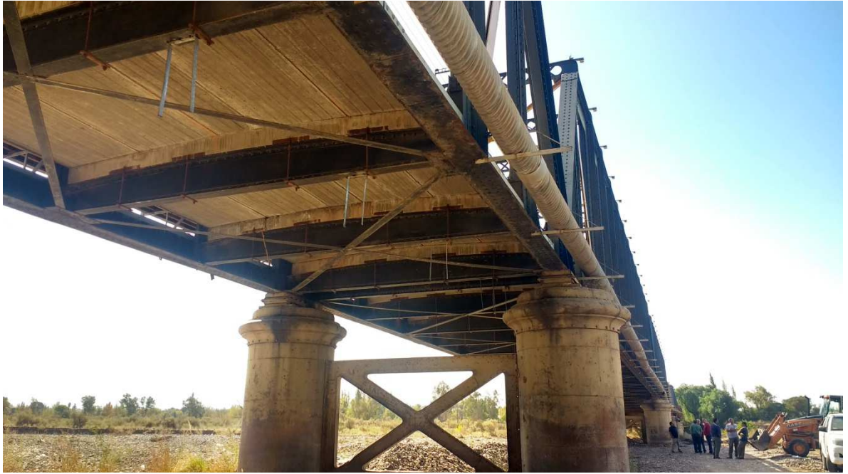
Figura 9. Viejo puente Rio Mendoza.
