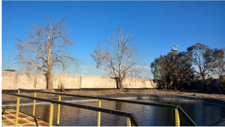
Figura 22. Instalaciones de Verallia y reservorio existente.
