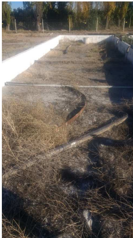
Figura 34. Piletas de secado de lodos.
