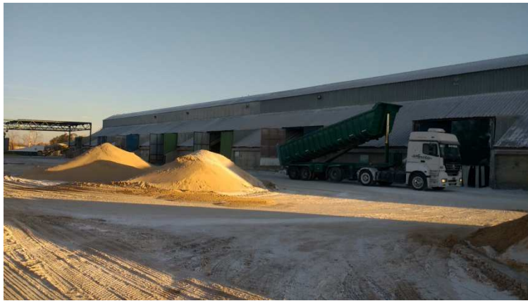
Figura 20. Instalaciones de Verallia.
