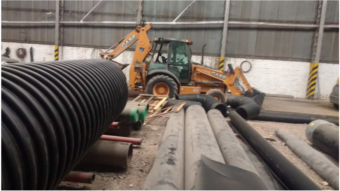
Figura 6. Tuberías Pead y geomembrana.
