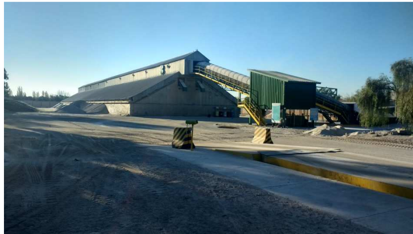
Figura 23. Instalaciones de Verallia.
