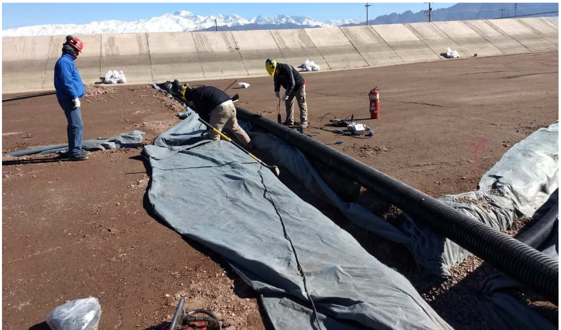
Figura28. Instalación sistema de drenaje.
