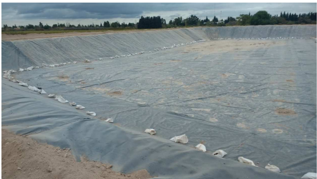
Figura 18. Fin de Obra
